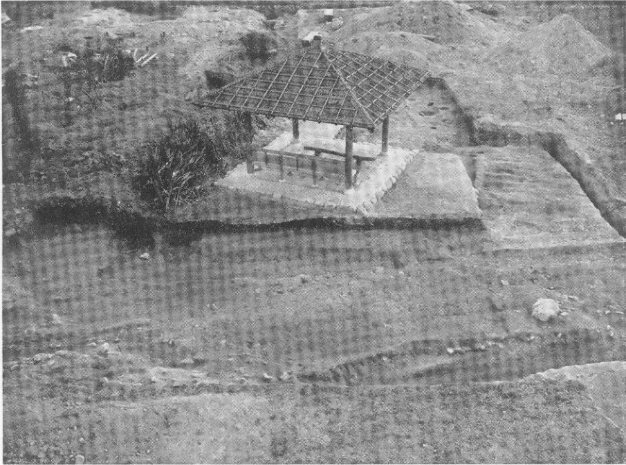
図版4 SC080 回廊跡(北から) H.I地区
