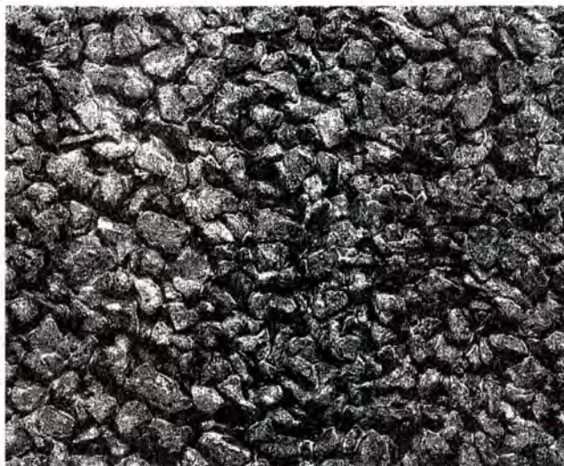
透水性コンクリート舗装の表面
