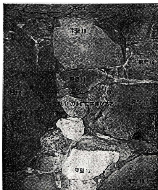
東壁の前面の隙間と石組の状況
