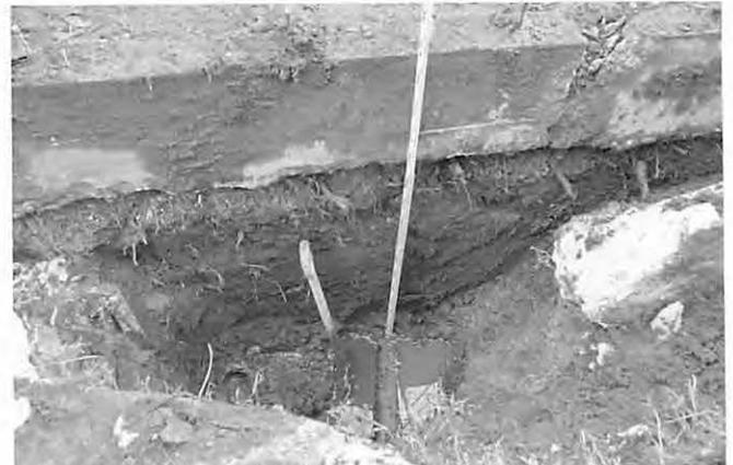
南北に通っていた。樹木周囲には円型のウッドデッキが設置されており、基礎は厚さ15cm程度の板状のものを約50cm間隔で立てて配置している状況であった。基礎の解体に相当の時間を要することから、基礎は残しその間を掘削した。当初、樹木の西半分のデッキを解体して掘削をおこなったが給水管が発見できず、東半分も解体して掘削をおこなった。樹木の根本の南東部、南側から2つ目の基礎間で、図面よりやや東側で給水管及び破損箇所を発見した。地表下約1.4mで給水管を検出した。湧水
