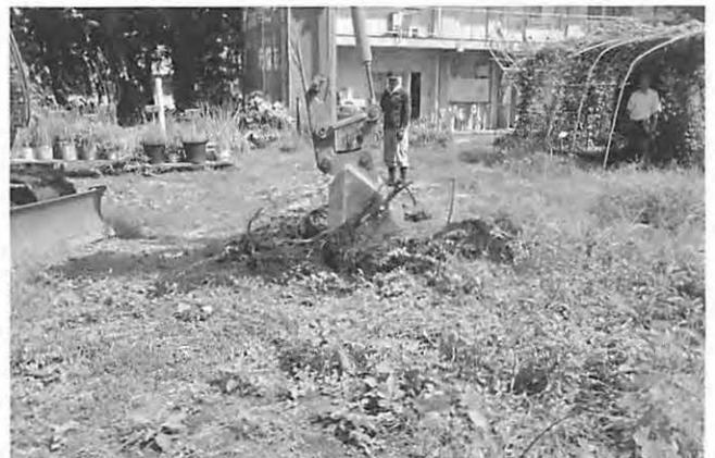
削して重機で引き上げた。除根後の凹みは3.2×2.6m、深さは0.8mである。地表下0.7m付近から砂質の層を確認した。
