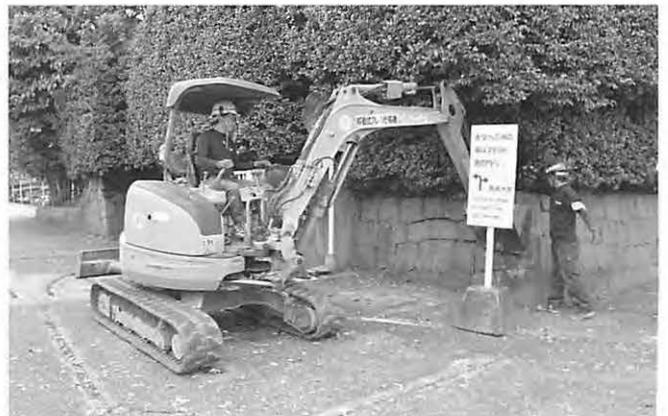
写真23 ⑧区裏込め除去作業風景（西より）
