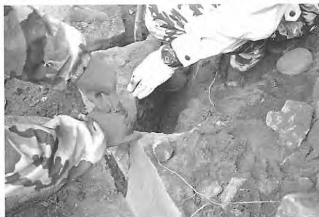
③地点も他の地点と同様で、盛り土を撤去したのち、裏込めを確認した。上部2段のみの積み直しで、この範囲では遺構面(地山)は検出されなかった。慎重に裏込めを外して積み直すよう指導して、終了した。
