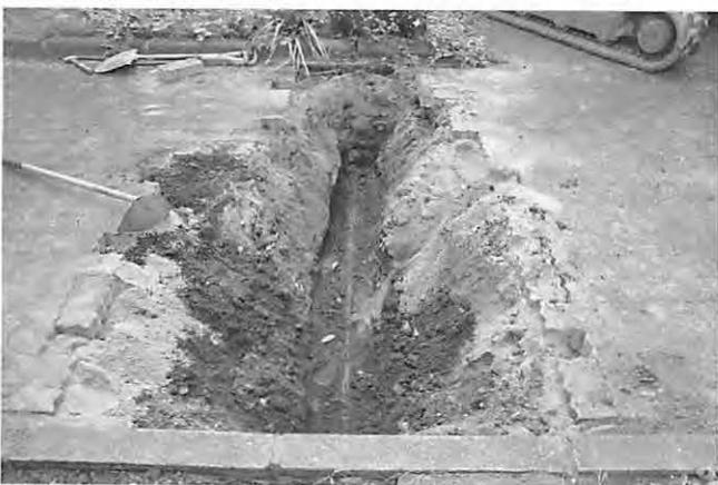
C地点は、大江E2建物の北東隅からガス管を繋ぎ、道路の北端を通して東側で再度繋ぎ変えて、ガス管を北側へ迂回させる工事である。地表下0.7~0.75mまで掘削した。西側から掘削を開始した。途中、地表下0.6mで包含層かと思う綺麗な土層が検出されたが、古代の遺物が含まれず、瓦やガラス片が含まれており、近代の土層と考えられた。掘削はこの土層までで、埋蔵文化財への影響はなかった。
