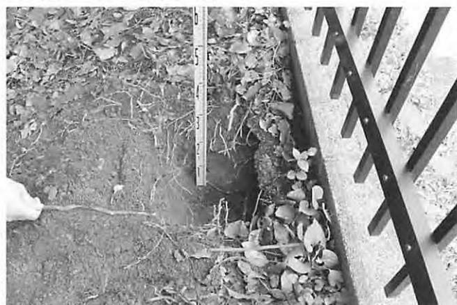
⑩は黒髪北地区北端の教育学部棟の北側にあたるフェンス撤去に係る工事である。強い勾配で傾斜した地形の上にフェンスが設置されており、この基礎周囲の東西33m、幅1.6mの掘削である。基礎部分を2カ所試掘したところ、基礎の引き抜きは地表下30cmの掘削で問題ないとのことで、全て現代埋土内におさまるため、工事業者に指示を出して掘削を進めさせた。
