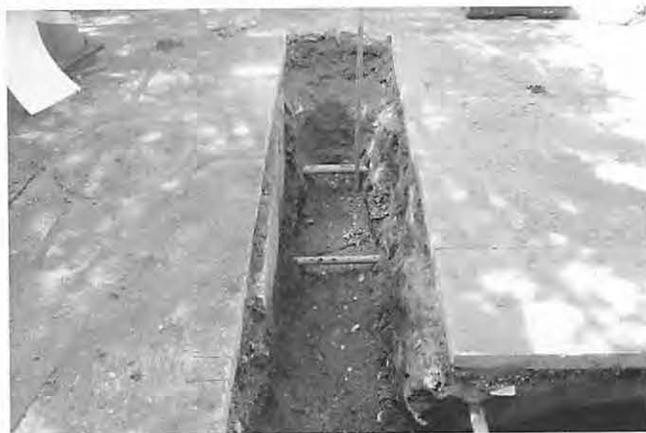
B地点は、薬草園の畑をはさんでA地点の反対側に位置する。既往の工事設計図では、ここで東の畑へ伸びる管と北へ伸びる管とに分岐していることになっており、東へ伸びる管を分岐点で切断する工事が予定された。予定箇所を掘削すると、予定ではクランク状になった水道管が検出されるはずであったが、一直線に東西に走る水道管で、北への分岐した管は確認できなかった。このため、ここでの予定工事は断念した。この掘削は既設管の掘方内で埋蔵文化財への影響はなかった。
