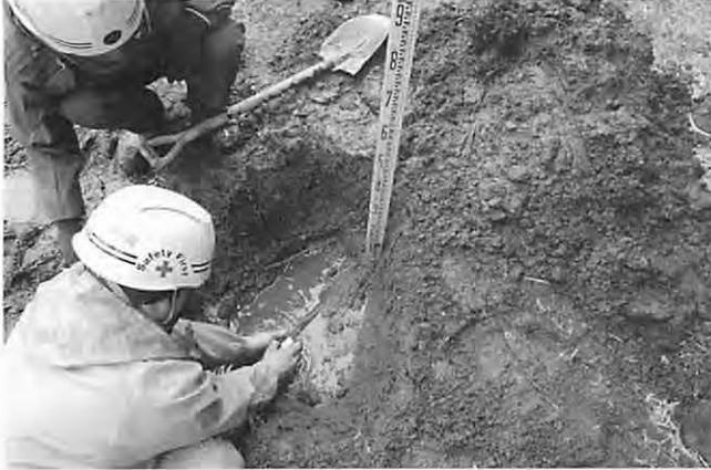
写真51 管下掘削状況（東より）
