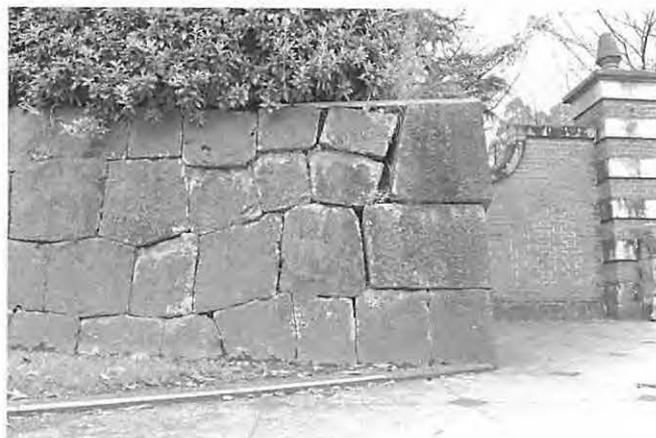
④、⑤、⑥、⑧は黒髪北地区を囲む石垣南辺の修復に係る工事である。これらは明治22年に竣工した第五高等中学校の石垣に相当する。石垣は南辺東側の数メートルが部分的に校正に積み直された痕跡が確認できるが、それ以外の多くは製造当時のものと考えられる。施工箇所は熊本地震によって積み上げられた石材が大きくずれた箇所にあたる。
