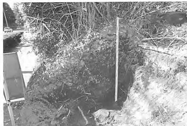
面(地山)の掘削は上部のほうがやや開く(幅広い)ようである。①地点は最下段まで撤去せずに、下3段は残して上部のみの積み直しであった。このため、盛土から0.95mまでは掘削をおこない、以後は間知石を外しながら裏込めを丁寧に撤去して積み直すよう方法を確認して終了した。
