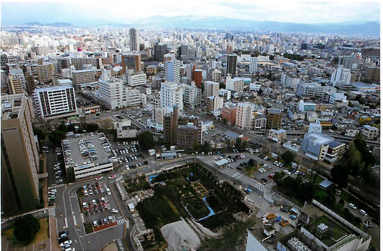
2. 本荘北地区 1708 調査地点航空写真（西より）
