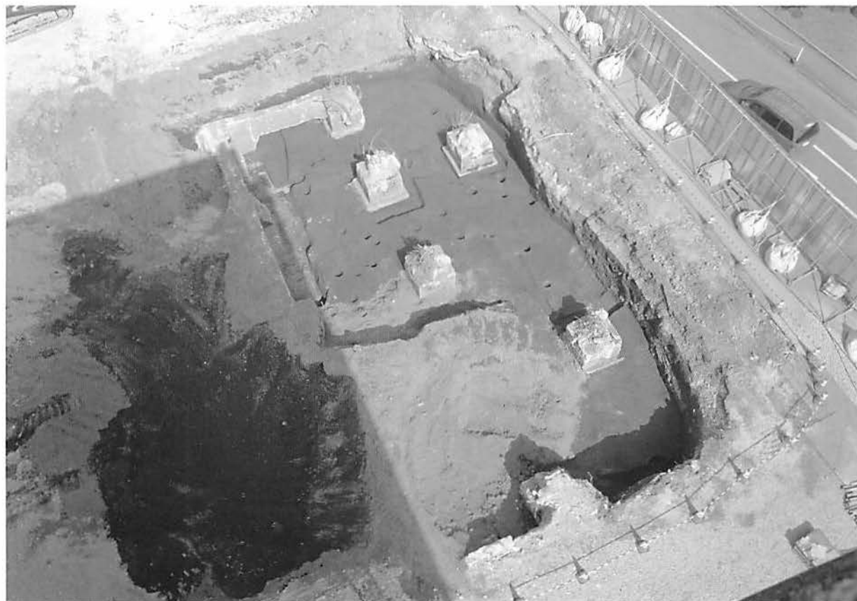
写真11 u～z-10～12グリッド掘削状況（西より）
