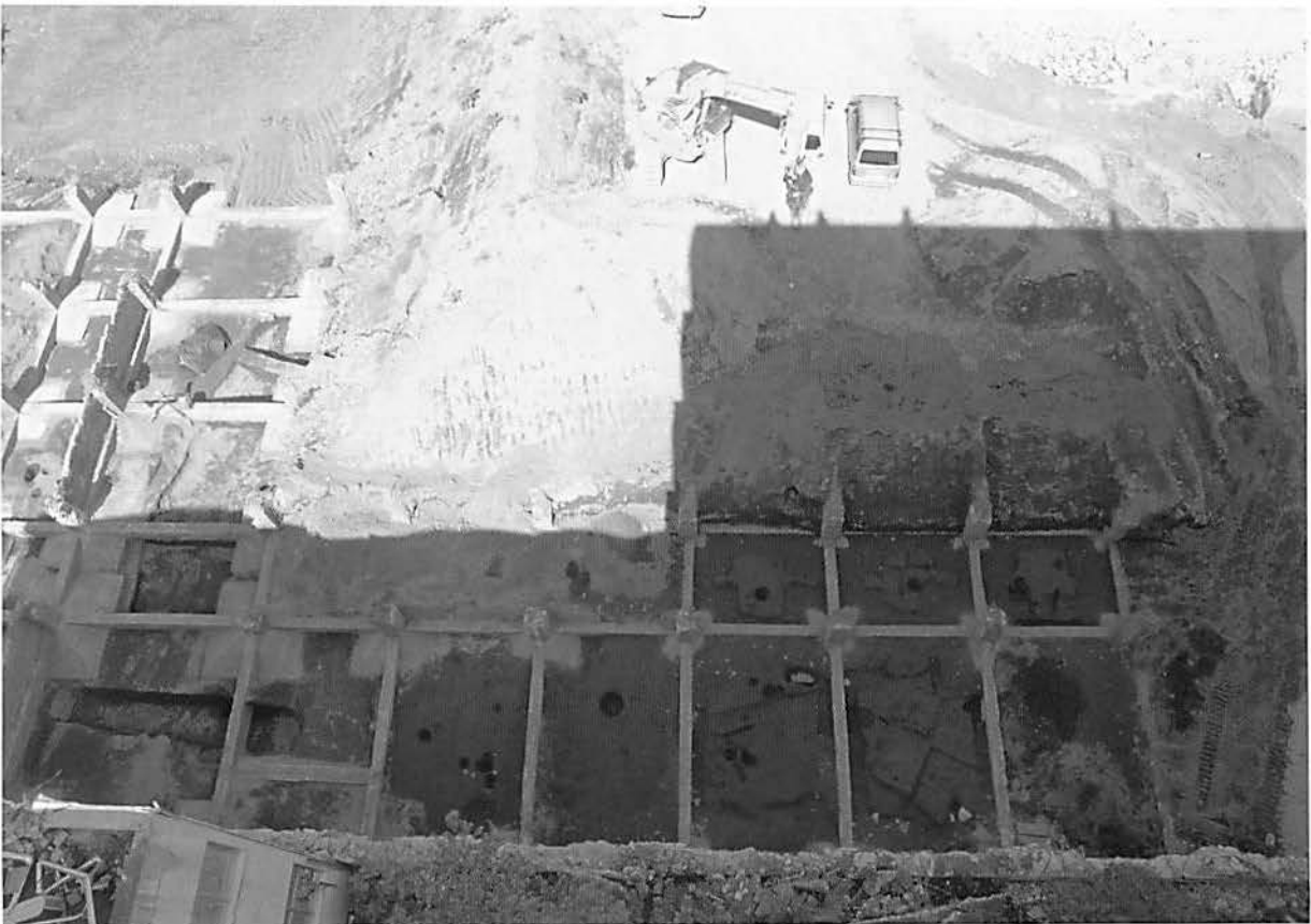
写真2 A～E-1, AB-1～9グリッド掘削状況（西より）
