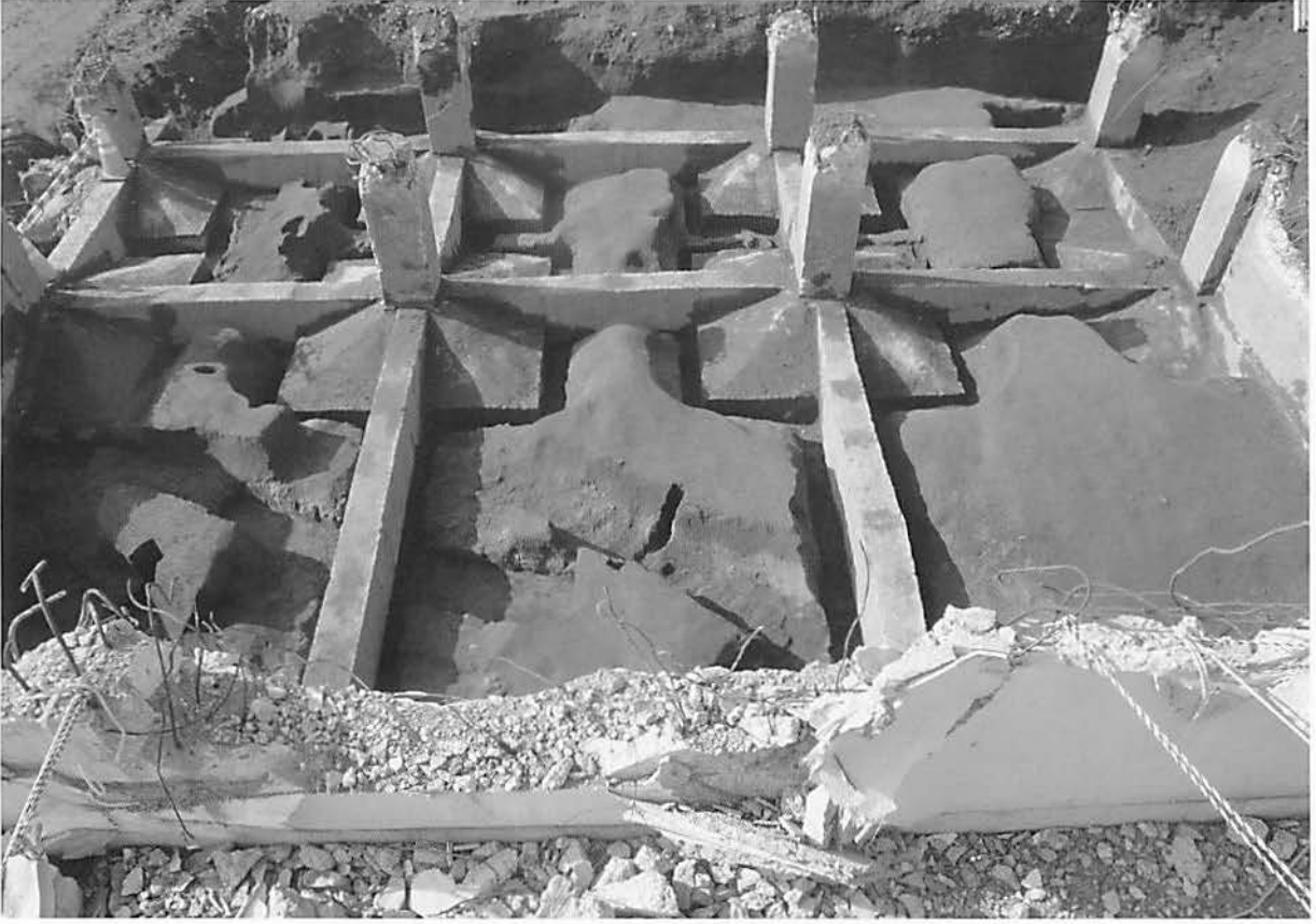
写真5 U-7~9グリッド掘削状況(東より)
