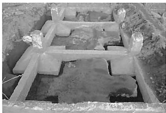
写真 47 217号道路Q~S-10 グリッド完掘状況 (西より)
