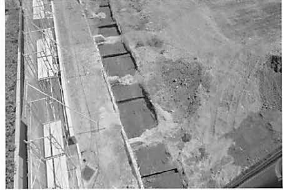
写真35 64号道路Ⅱ区北側硬化面1検出状況(西より)
