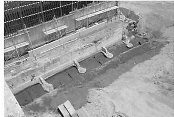
写真39 64号道路Ⅱ区北側硬化面4-2完掘状況(南より)
