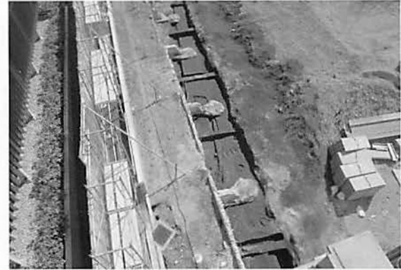
写真37 64号道路Ⅱ区北側硬化面3検出状況(西より)
