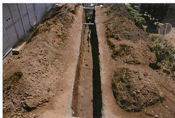
写真29 Ⅲ2区南側完掘状況（北より）
