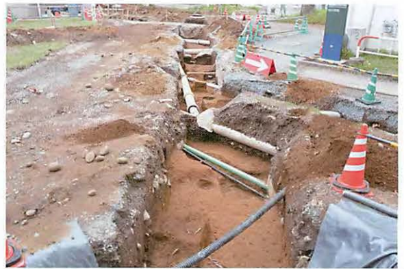
写真58 V11区古代遺構完掘状況(西より)
