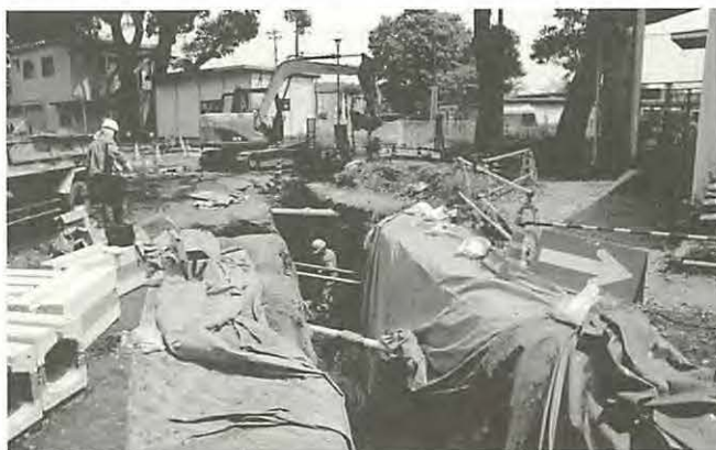
図72 調査区遠景（南西より）
