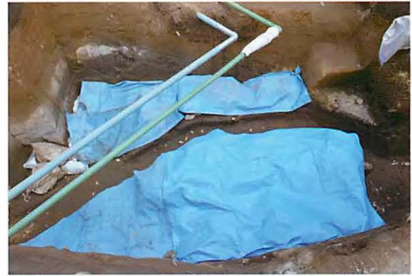
写真80 V11区拡張区ブルーシート養生状況 (南東より)
