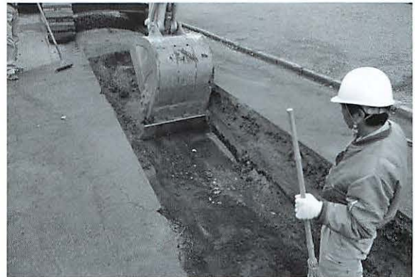
写真59 西側管路部分掘削状況（東より）
