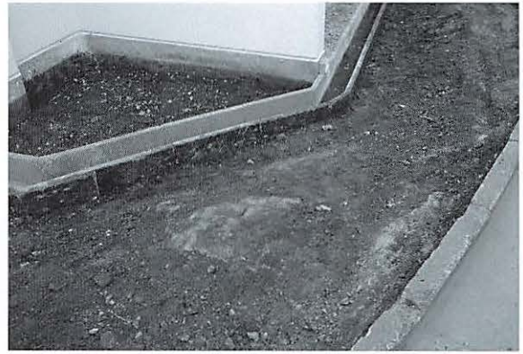
写真40 2号建物基礎検出状況（北より）
