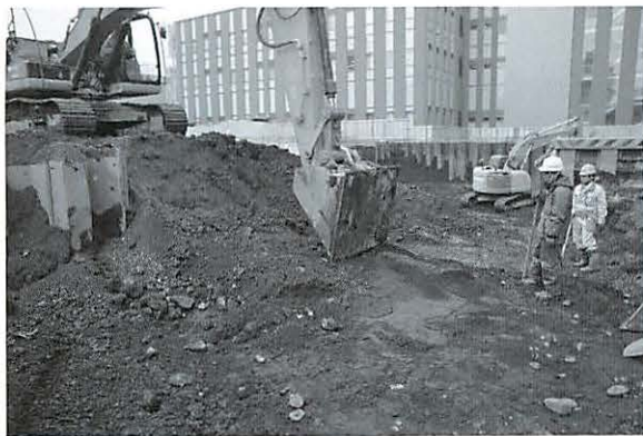
写真255 西部掘削状況（北より）
