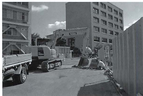
写真48 ②区作業風景 (南西より)
