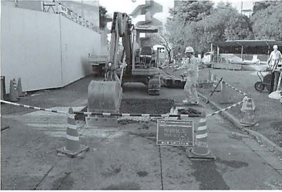
写真54 中央樹部分掘削状況（北東より）
