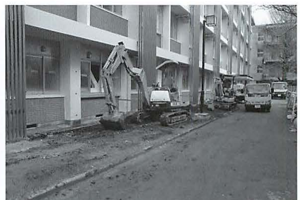
写真32 5区作業風景（西より）
