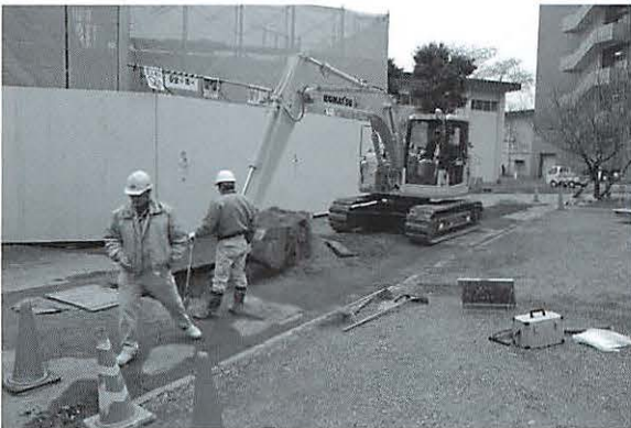
写真58 西側管路部分掘削状況（北東より）
