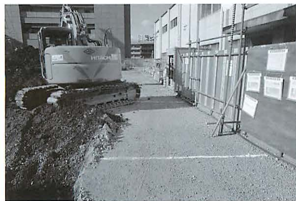
写真261 東部掘削状況（東より）
