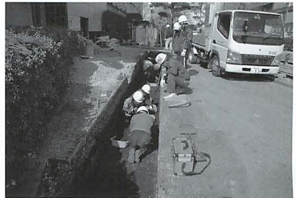
写真28 7区東側作業風景（南より）
