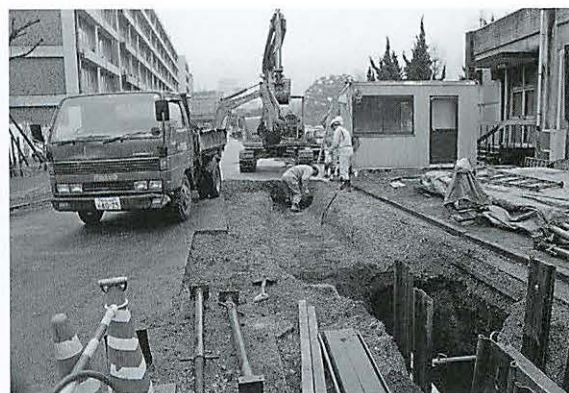
写真156 ⑧区間作業風景 (西より)
