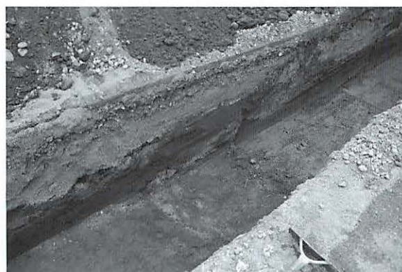
写真68 西側管路部分砂層検出状況（北より）
