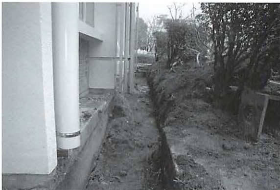
写真29 7区掘削状況（西より）
