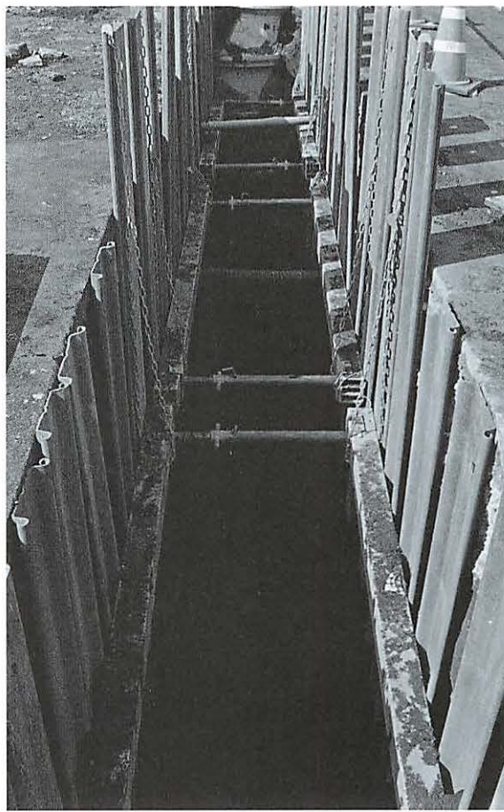
写真174 ⑧-3区間全景 (東より)
