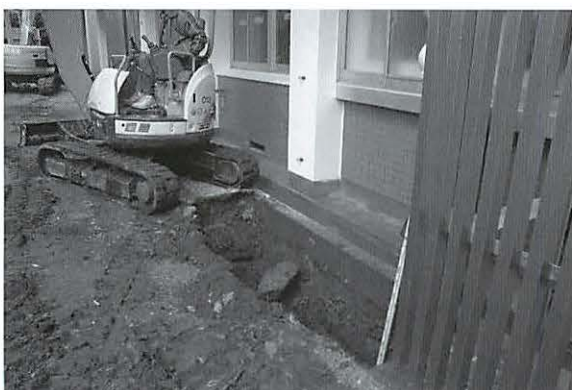
写真31 5区掘削状況（東より）
