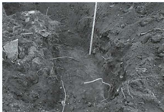
写真71 樹木③北側掘削状況（東より）
