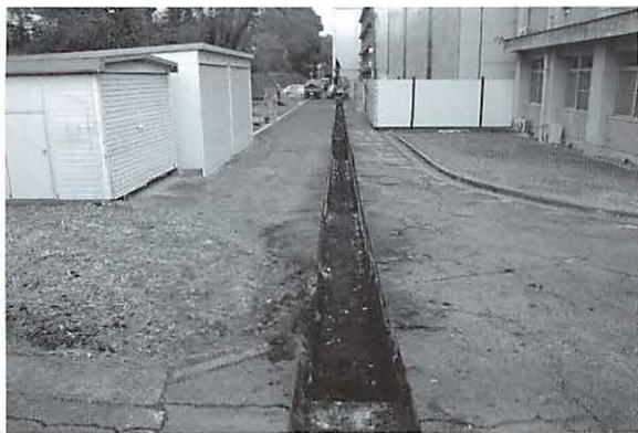
写真1 1区掘削状況(西より)
