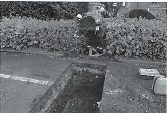
写真13 3区作業風景(西より)
