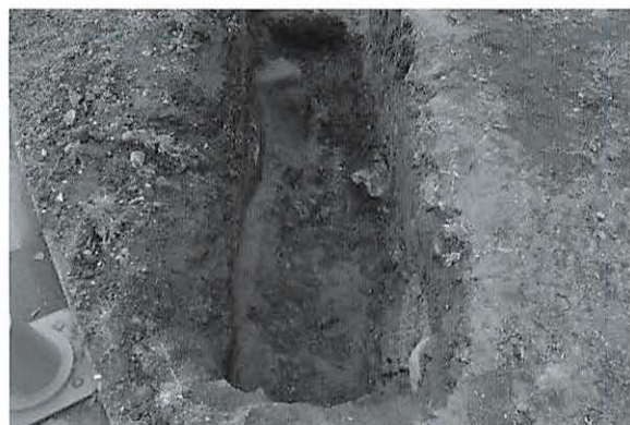
写真46 ①区東側全景 (東より)
