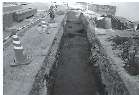
写真69 西側管路部分全景（南西より）
