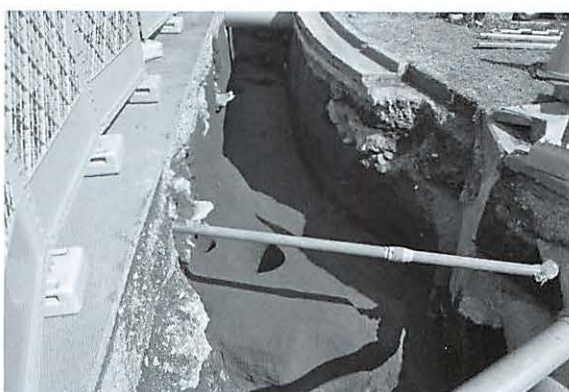
写真182 III区西側全景 (南西より)
