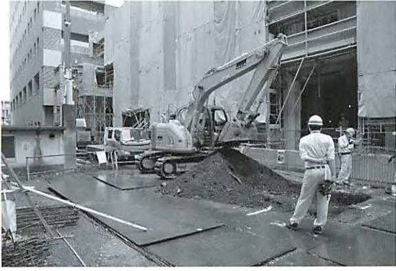
写真263 掘削状況（南東より）
