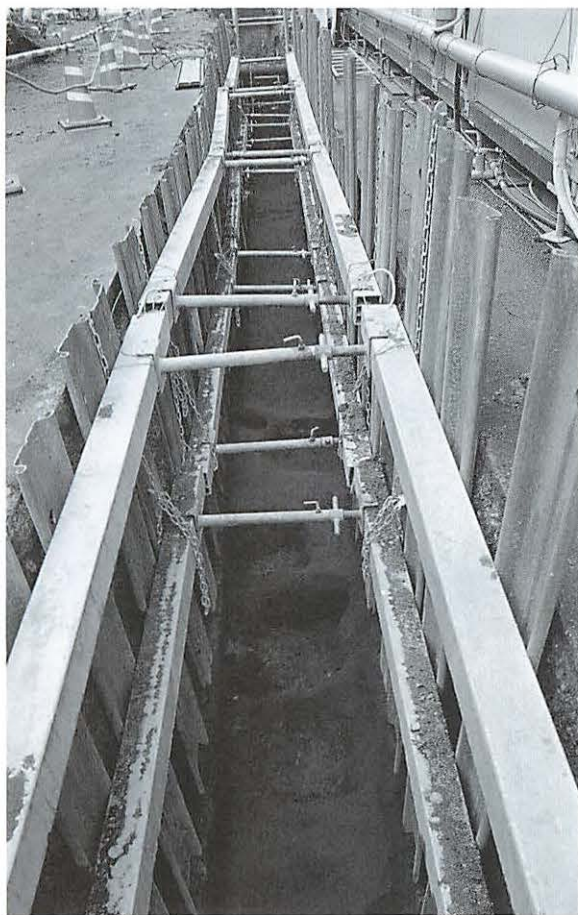
写真173 ③区間全景 (南より)
