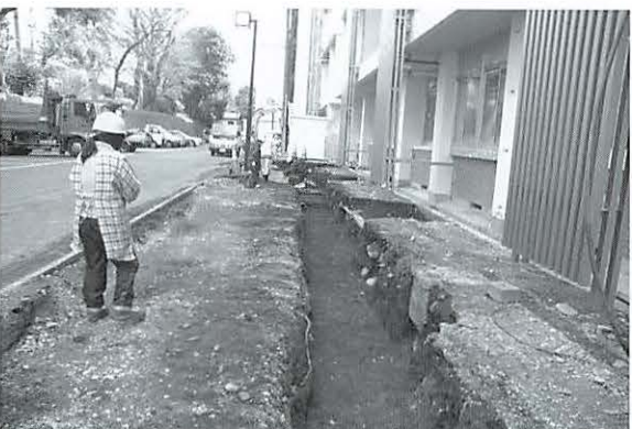
写真15 4区掘削状況(西より)
