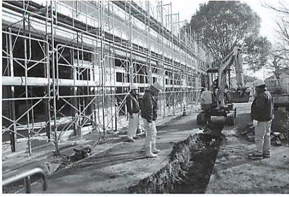
写真33 掘削状況（西より）
