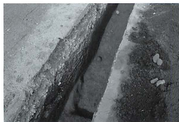
写真52 2号溝掘削状況 (西南より)
