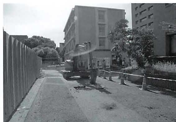
写真51 ⑤区作業風景 (東より)
