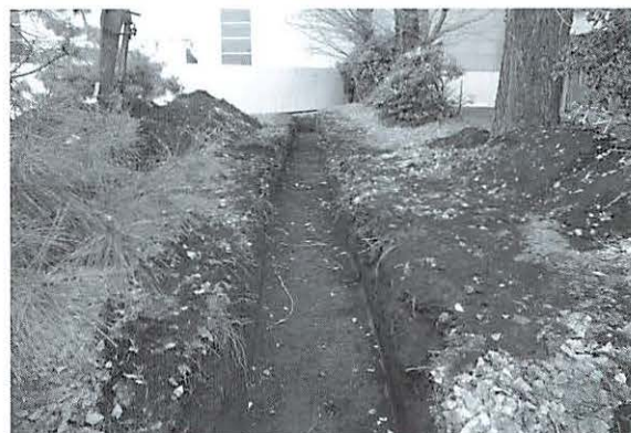
写真6 2区掘削状況(南より)
