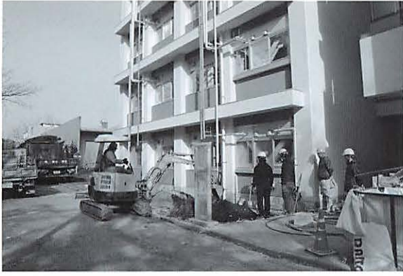
写真37 掘削状況（南東より）
