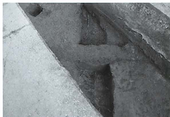
写真65 1号溝掘削状況（東より）
