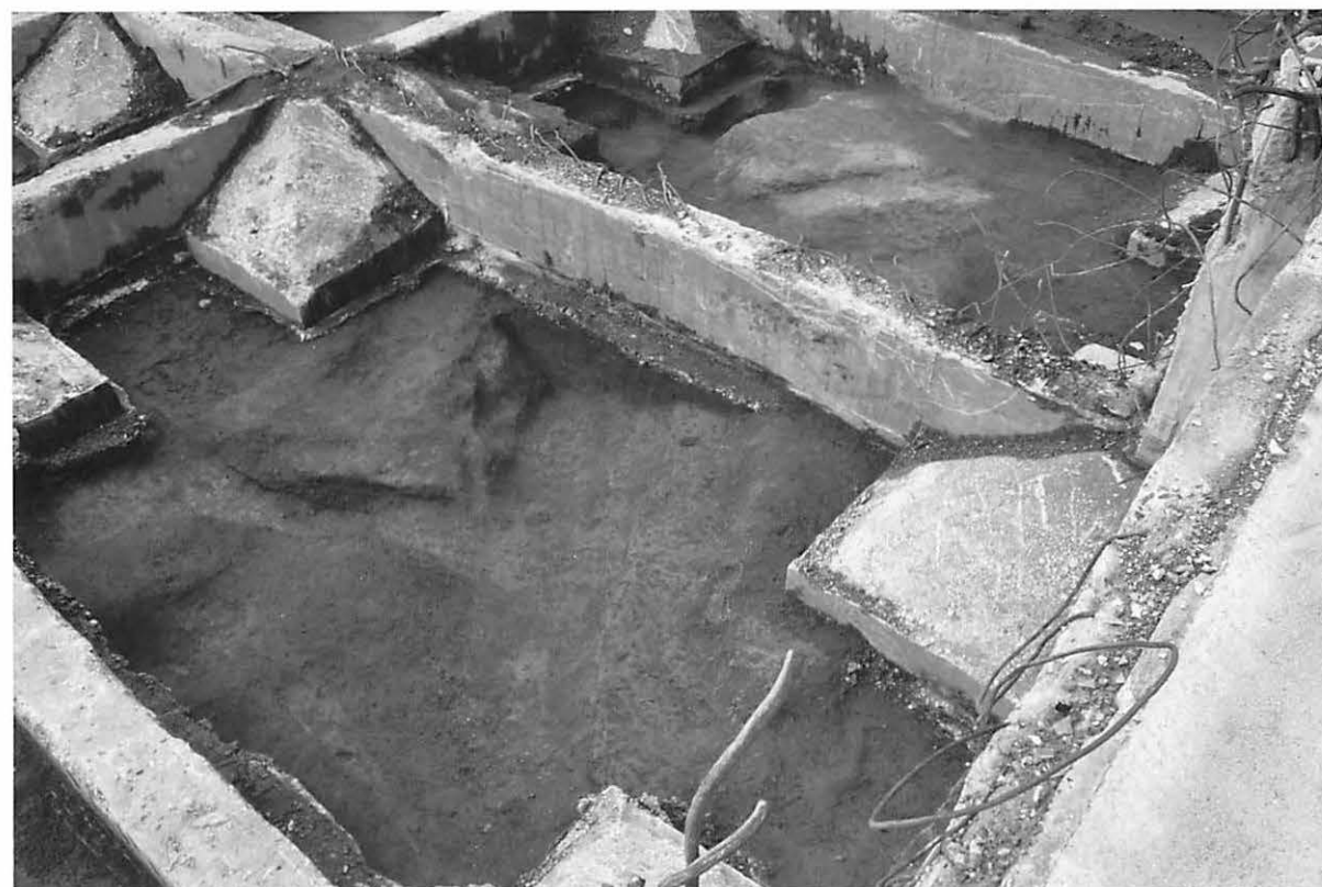
写真152 1号溝 南8・9区 (南西より)
