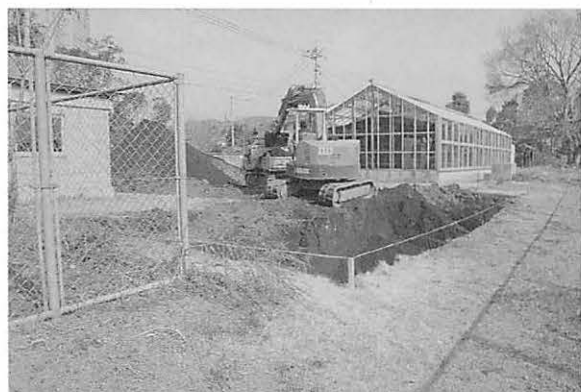
写真2 1次掘削の様子(南より)
