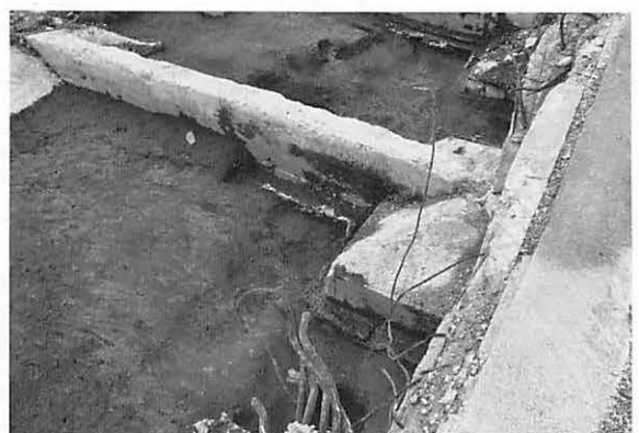
写真157 1号溝 南12・13区 (南西より)
