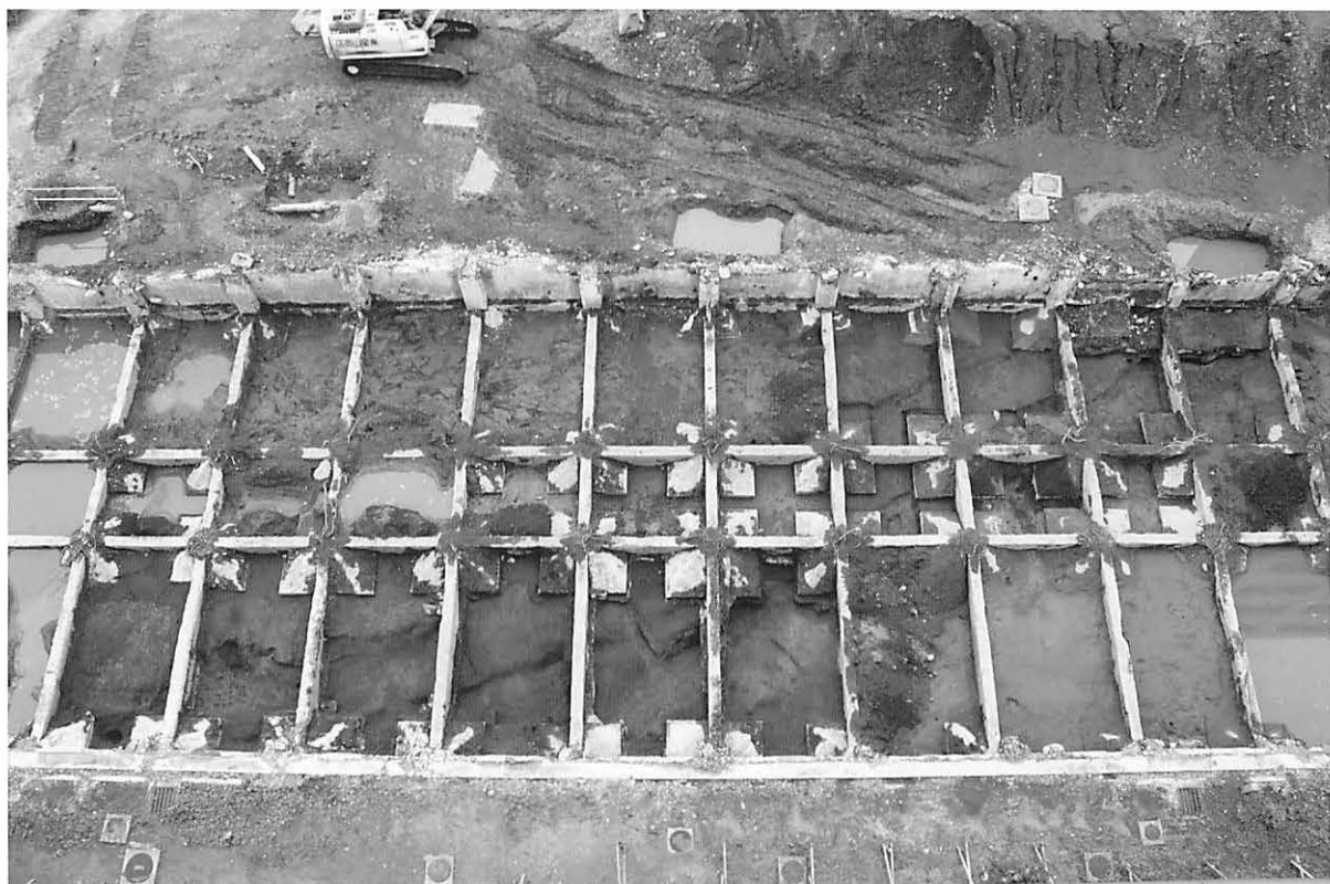
写真141 調査区全景 (南より)
