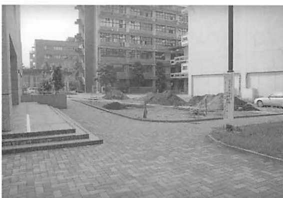
写真58 III区調査地点全景（北東より）
