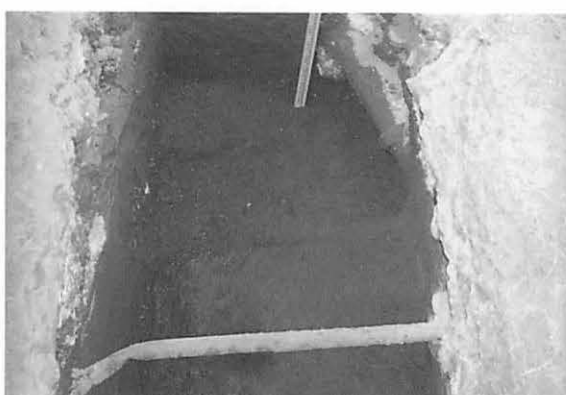
写真54 II区トレンチ1掘削状況（西より）
