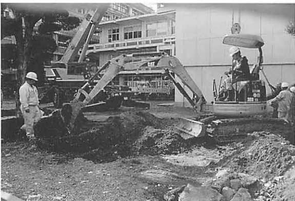
写真73 トレンチ18位置換え掘削風景(北より)
