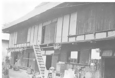
民家（中山，平形政英家）出し梁になっ ている部分には下からはしごで上るよう になっている。
