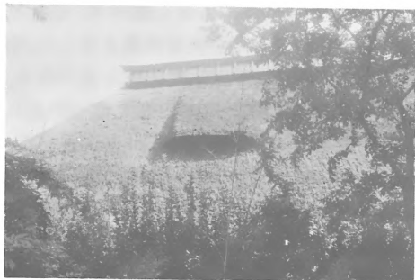
煙出し（横室）昔の家屋は通風の設備がなかった。これは紺周郎銅の頃の煙出し。
