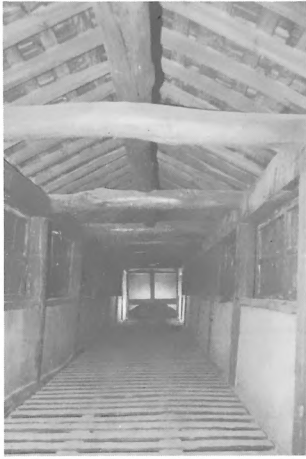
民家構造（島村） 棟上の高樓の内部。 床は通風のよいよ うスノコ状になっ ている。
