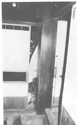
写真 42 小倉真佐留家の大黒柱 約沢角で四面にカンナがかけ られ逃げもある。
