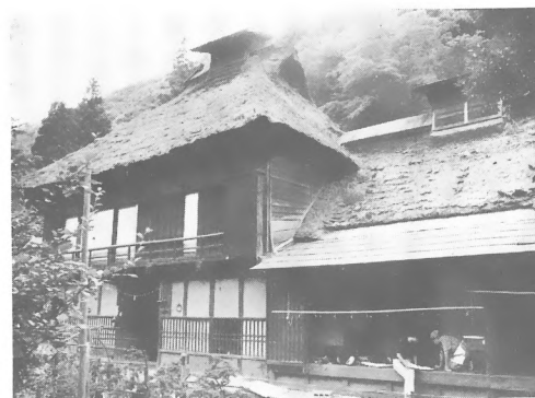
写真7 関口宗佑家(広間型)(大正2年にグ イドコロ部分を改造し2階とする。)
