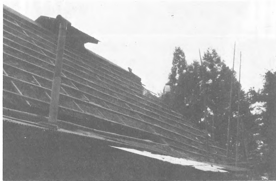
トタン屋根をふくところ。(浅原) (撮影 板橋春夫)
