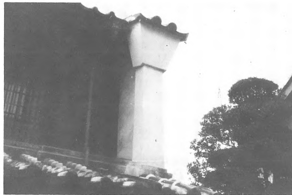
ウダツ。町の大半が大火にあったため、町家にはウダツがめだつ。(大間々) (撮影 板橋春夫)
