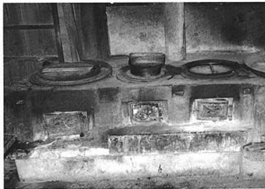
16 セメント仕上げのクド
