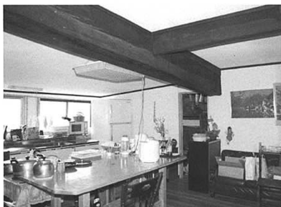
↓ 台所の釜屋差 中原季雄家
