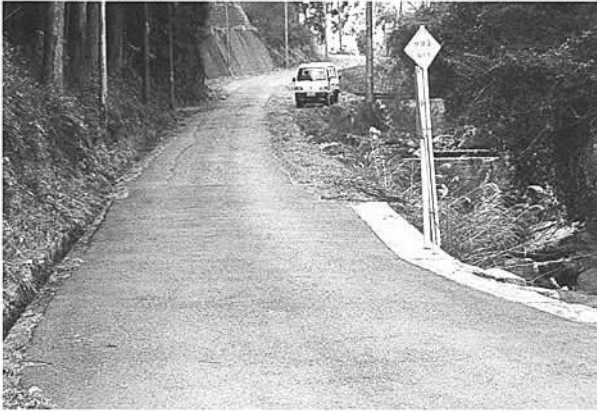
5 釜の河内入口
