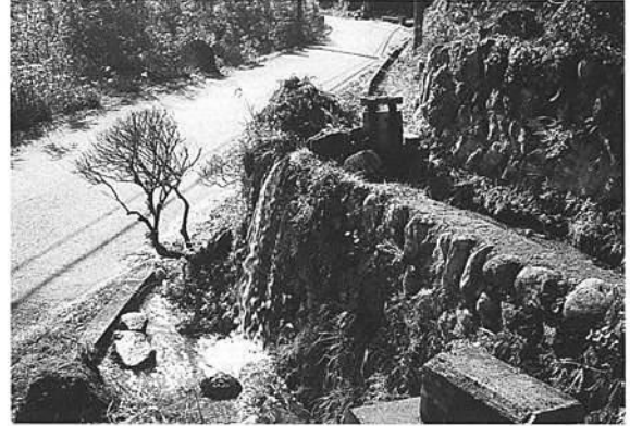
62 広瀬への溝と水抜き装置 (南方向を撮影)。
