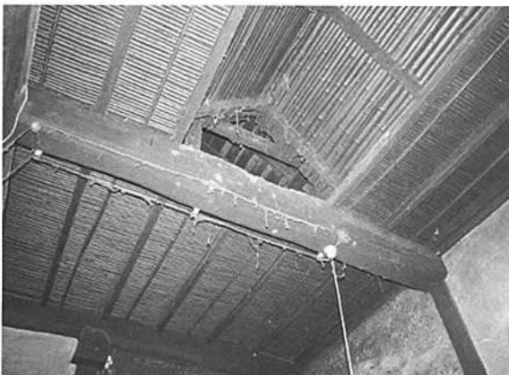
↓ 棚元の煙出し 中原季雄家
