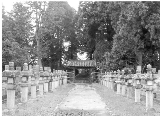
写真2 墓所西区正面（東から）
