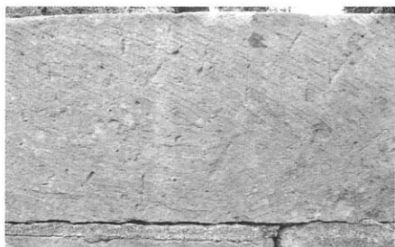
写真6 藩主墓縁石 表面平ノミ加工痕
