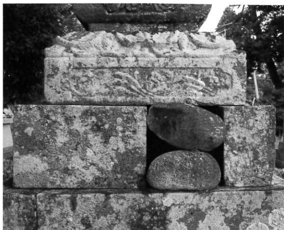
基壇東面 礫石経投入口 補修痕
