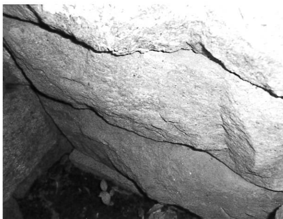
基壇内部 石材加工状況
