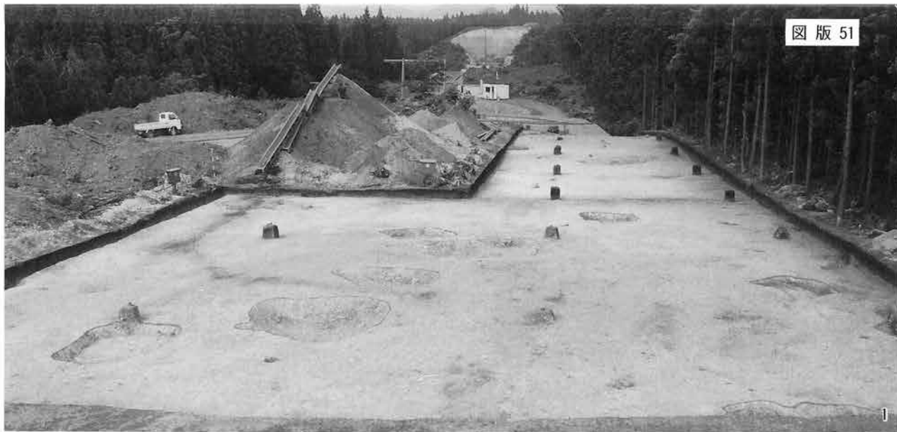
1 東側南部 完掘 (西から)
