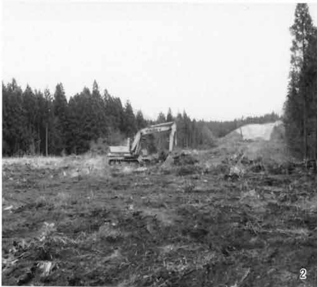
2 調査前 (西から)
