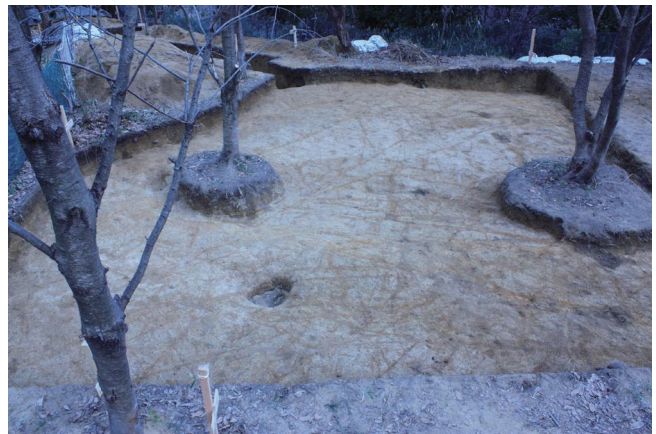
写真12 曲輪90 第16-16トレンチ 北から
