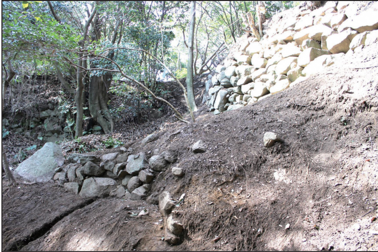
石垣 14 (右)、石垣 16 (左) 石垣 15 (奥)
