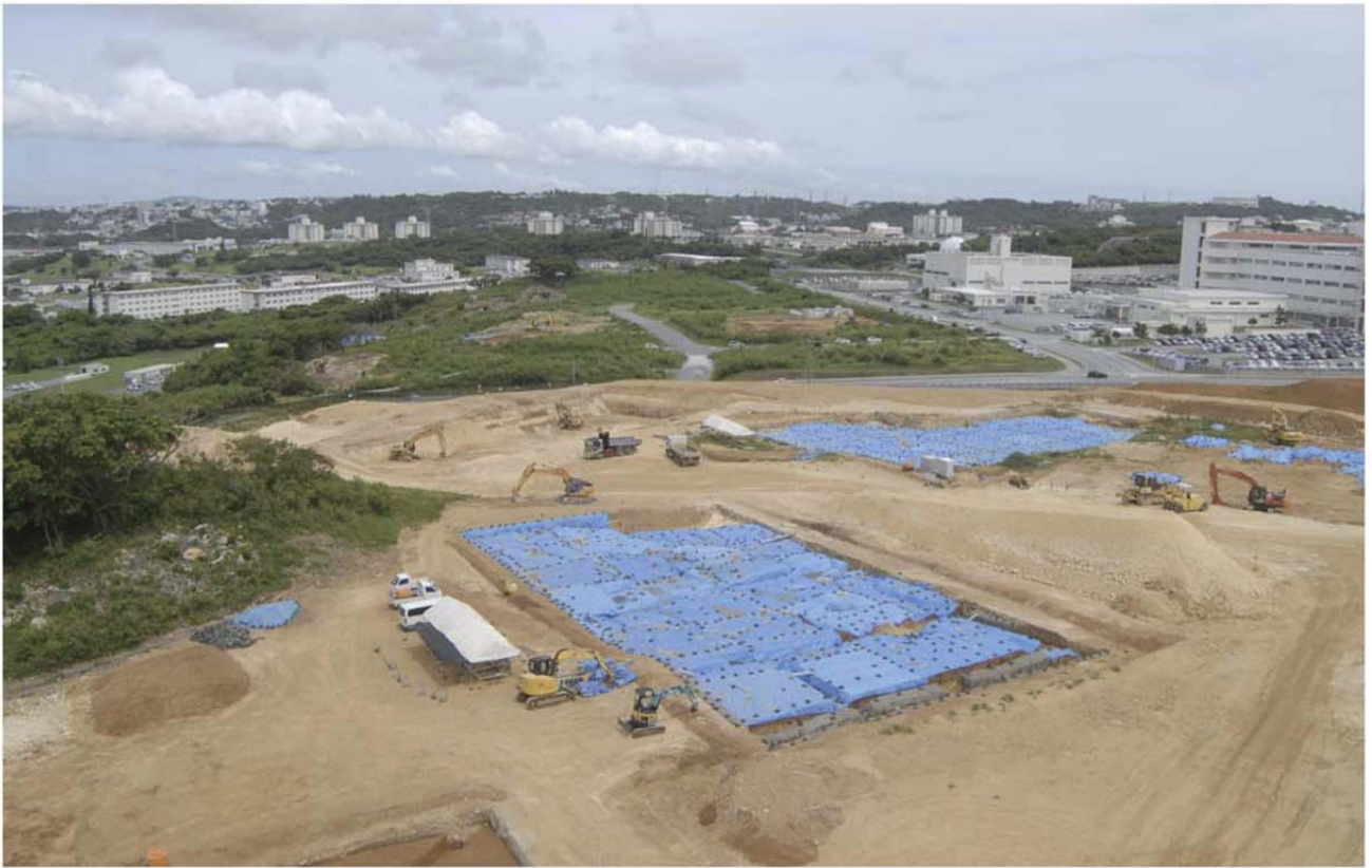
調査区 (8-②区) 近景
