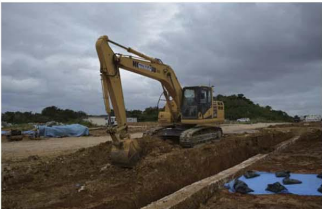
5-③区 重機掘削
