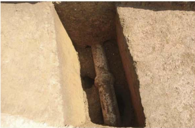
NS トレンチ 1 配管埋設状況 北から
