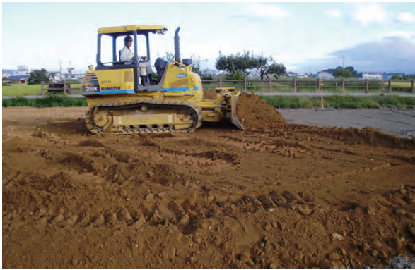
写資 1-9 1次造成工事施工中（敷均し）
