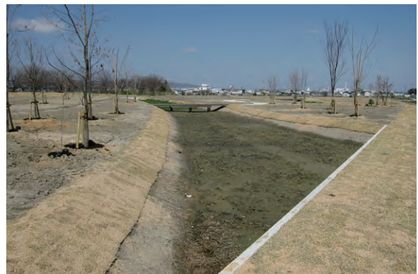
写資 1-36 東側環濠完成
