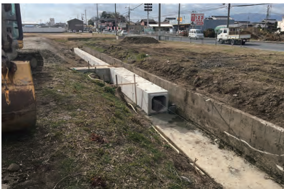
写資 1-15 水路工事（ボックスカルバート） 施工中
