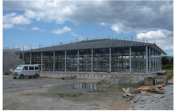
写資 1-50 建物鉄骨
