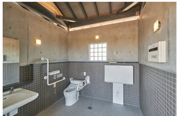
写資 1-68 便所棟の多目的便所
