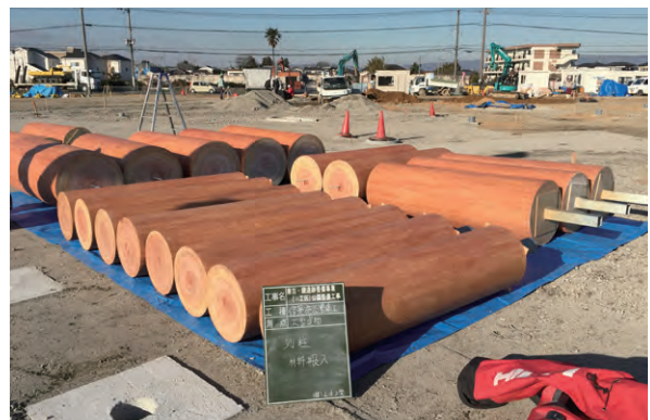
写資 1-22 柱素材搬入
