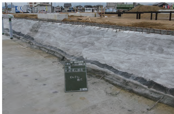
写資 1-46 環濠表現部モルタル荒仕上げ
