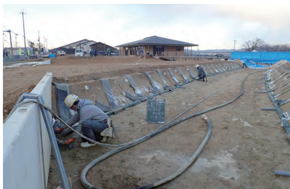
写資 1-41 裏面排水材設置
