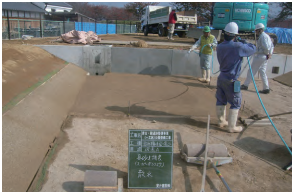
写資 1-39 西側大環濠真砂土固化舗装
