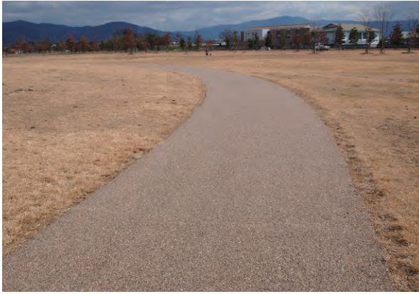
写 5-21 主園路（自然色アスファルト舗装）
