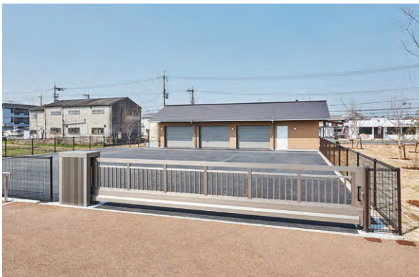
写資 1-71 倉庫棟と管理作業スペース
