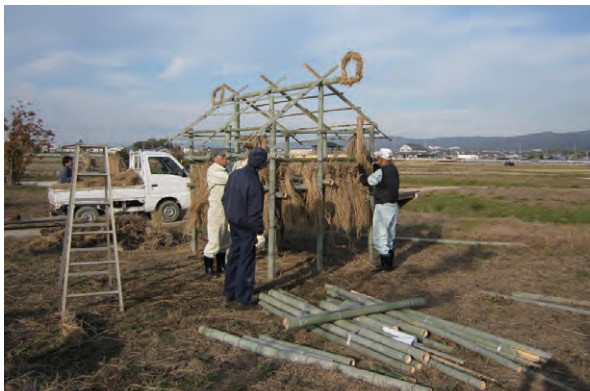
写6-7 わらアート試作 高床建物
