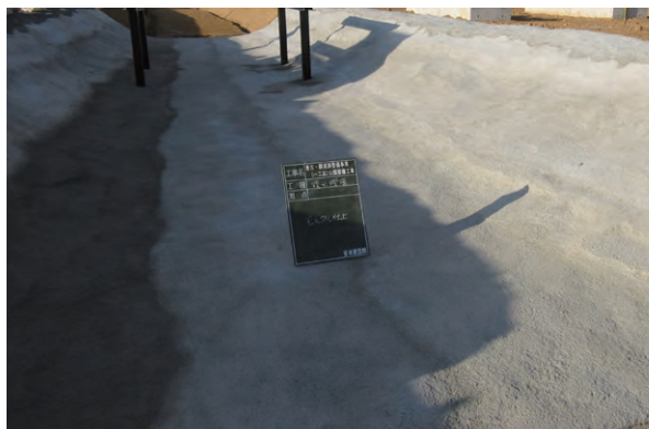
写資 1-47 環濠表現部モルタル成形仕上げ
