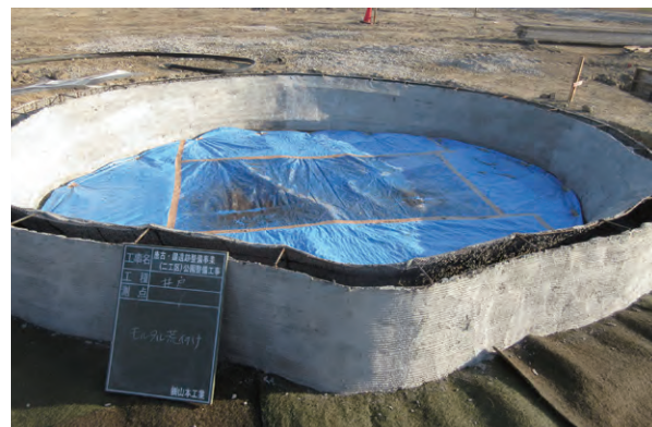
写資 1-28 モルタル荒仕上げ
