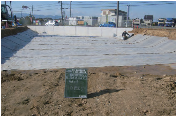
写資 1-37 西側大環濠防水シート
