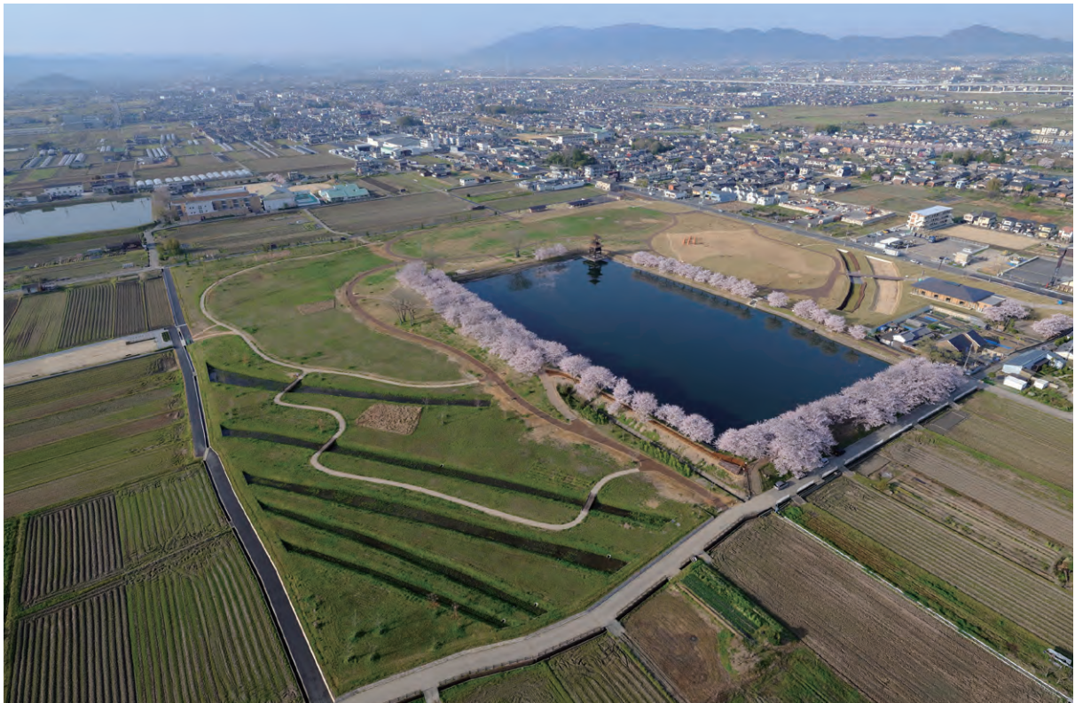
事業完了（北東から）
