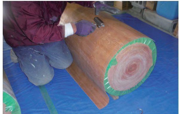
写資 1-18 柱素材木目シート貼付 1
