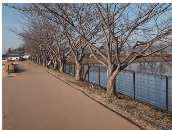
写 5-44 唐古池周辺のフェンス h1.2m
