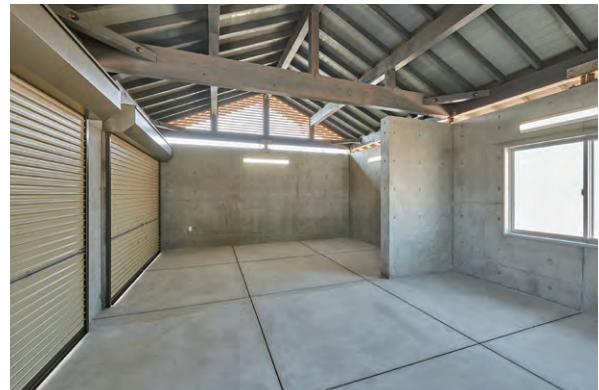
写資 1-72 倉庫内観
