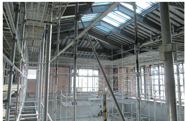
写資 1-52 内装作業
