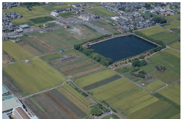
写資 1-4 事業着手前
