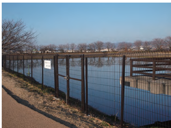
写 5-43 唐古池周辺のフェンス h1.5m
