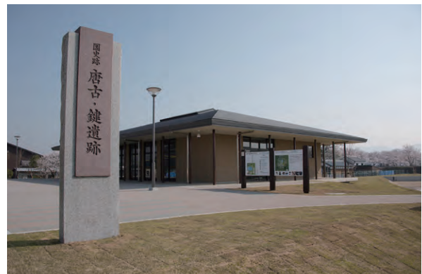
写資 1-56 完成（手前は国指定遺跡標識）
