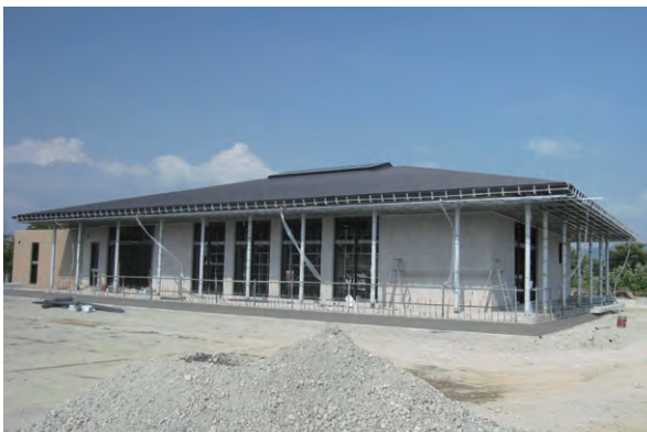
写資 1-51 屋根・壁完了
