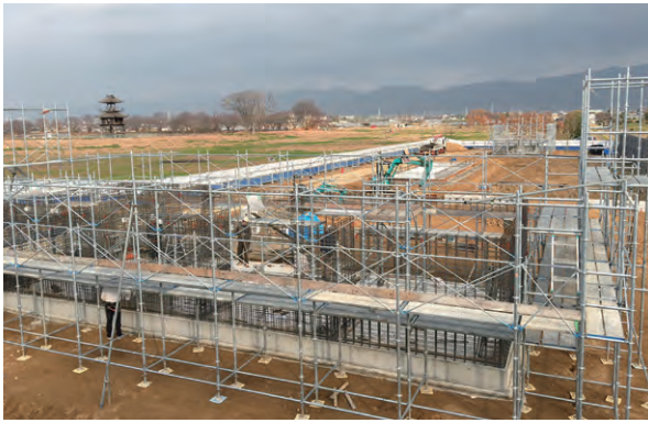
写資 1-65 倉庫棟鉄筋
