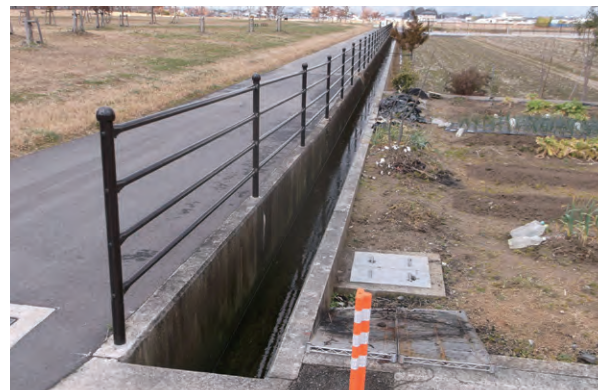
写資 1-16 水路工事（開水路）
