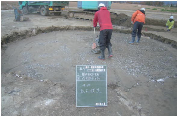
写資 1-25 碎石転圧
