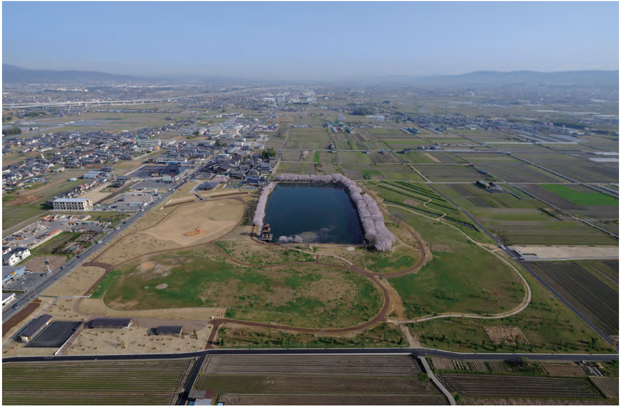
事業完了（南から）
