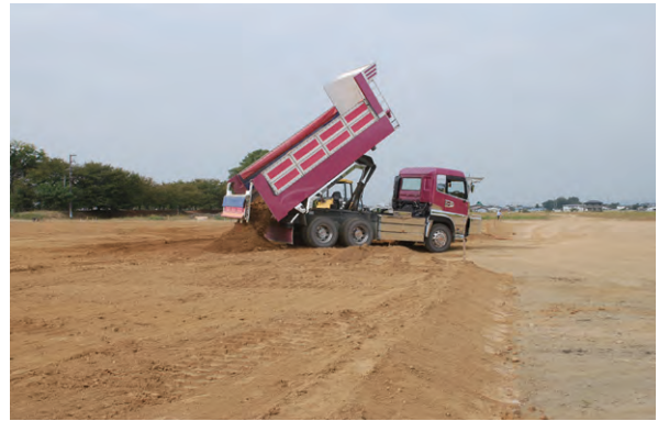
写資 1-10 1次造成工事施工中（土搬入）
