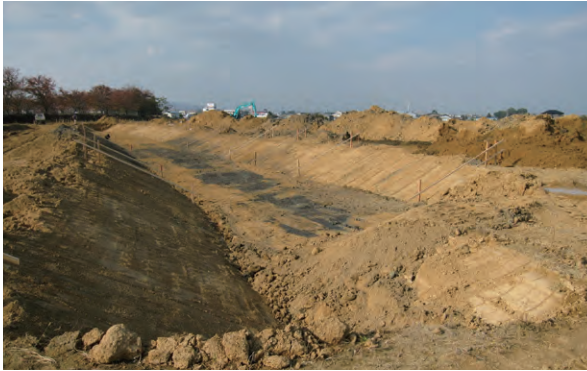
写資 1-33 東側環濠掘削
