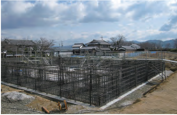
写資 1-49 地下ピット部鉄筋
