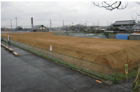
写資 1-11 1次造成工事完了
