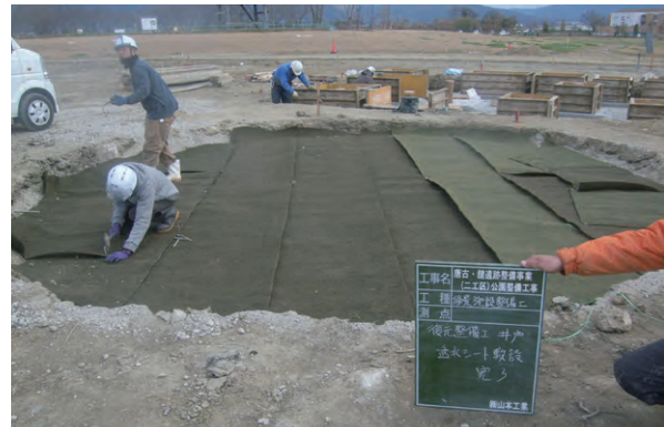
写資 1-26 透水シート敷設
