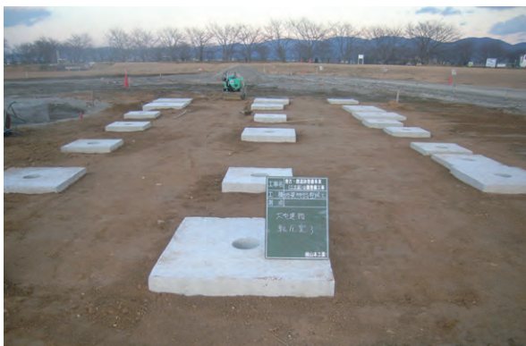
写資 1-21 基礎完了
