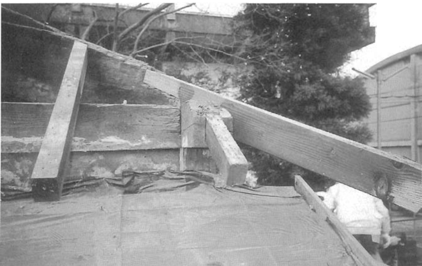
図版—61 番所解体
