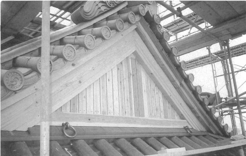
図版-42 大手門破風廻り瓦葺
