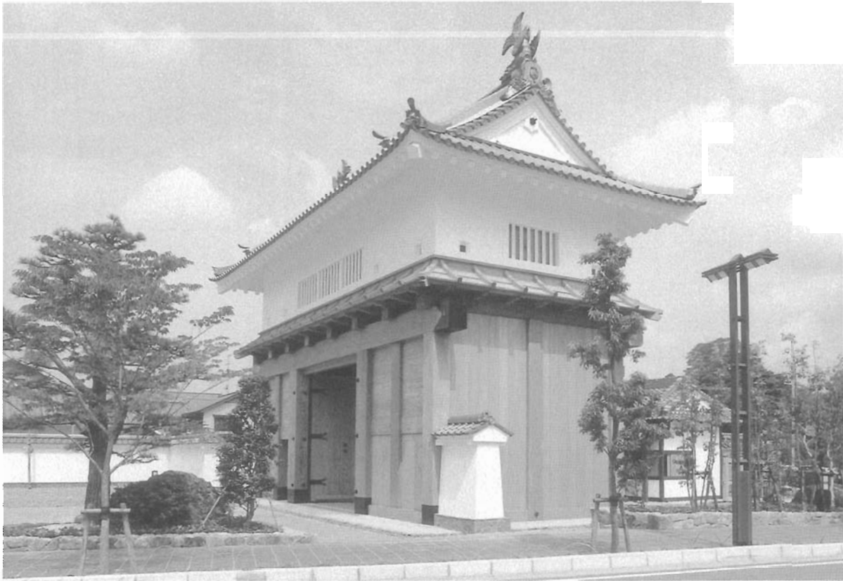
図版-14 竣工大手門東面
