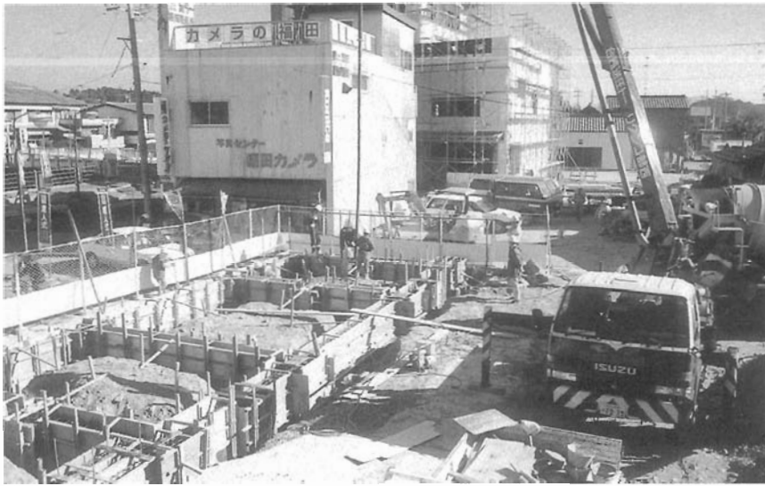
図版-23 大手門 基礎コンクリート打
