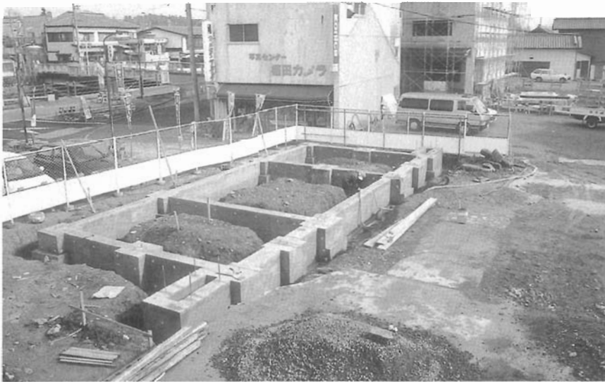
図版-24 大手門 基礎コンクリート出来形
