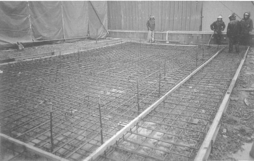
図版—66 番所土間配筋
