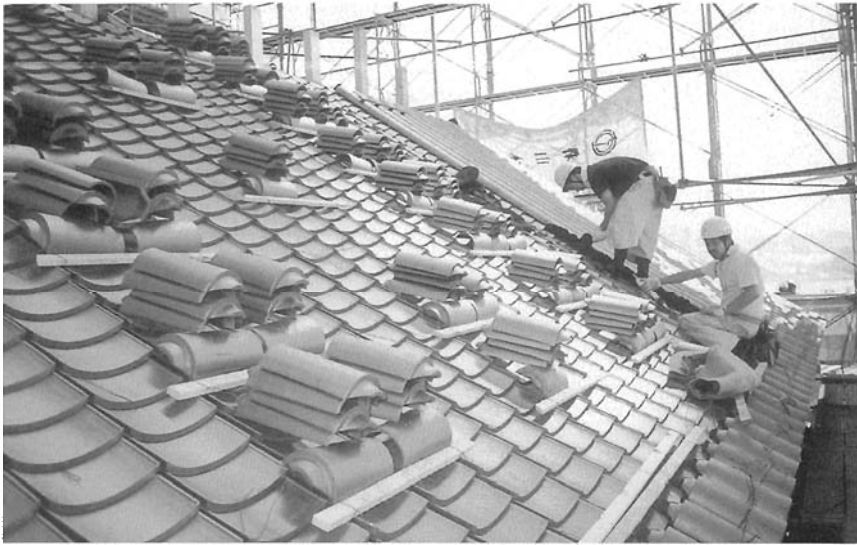
図版-41 大手門屋根丸瓦葺
