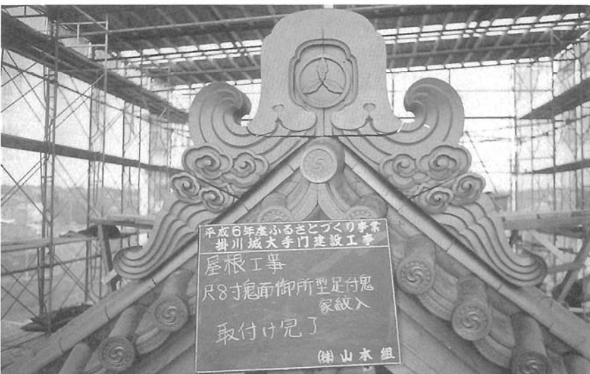
図版-43 大手門本棟鬼瓦据付
