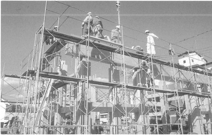
図版一29 大手門建方（冠木架け）
