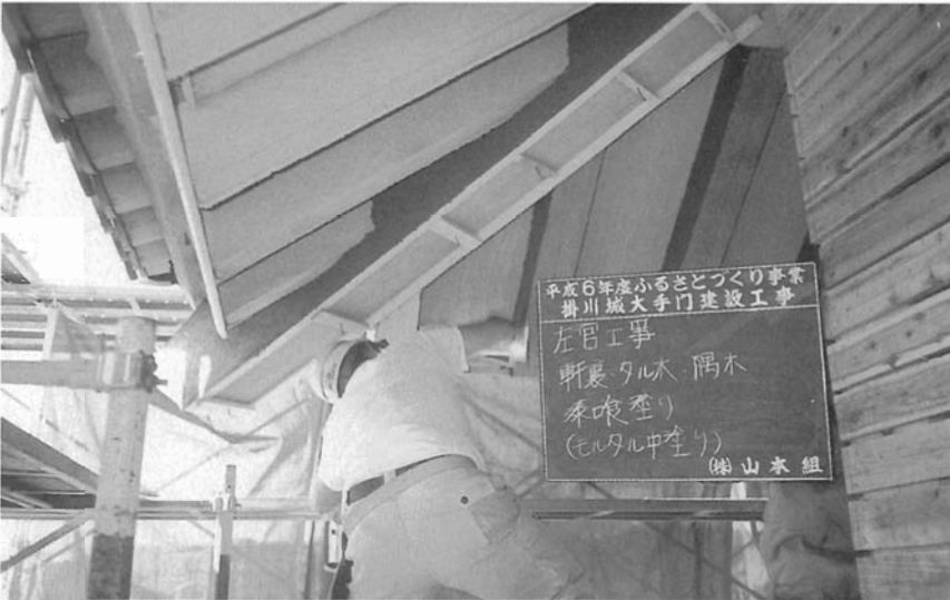
図版一48 大手門軒廻り漆喰塗り
