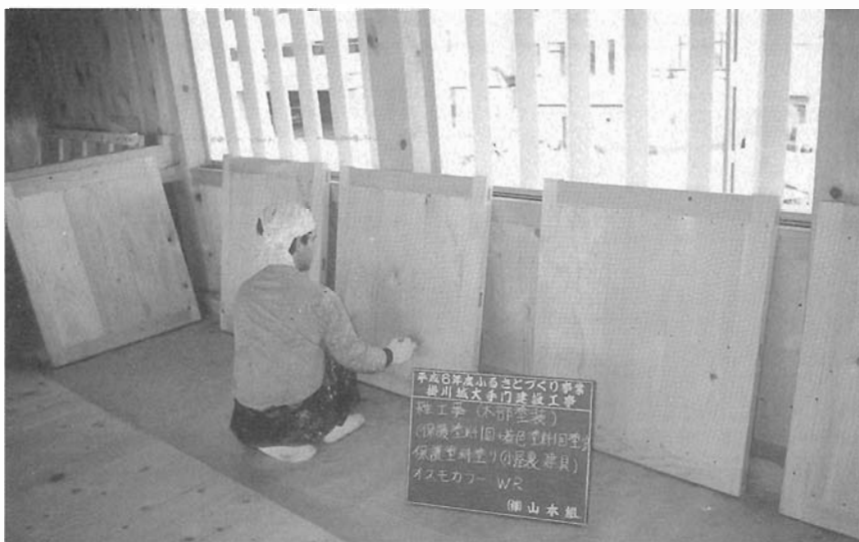
図版—51 大手門建具保護塗料塗り
