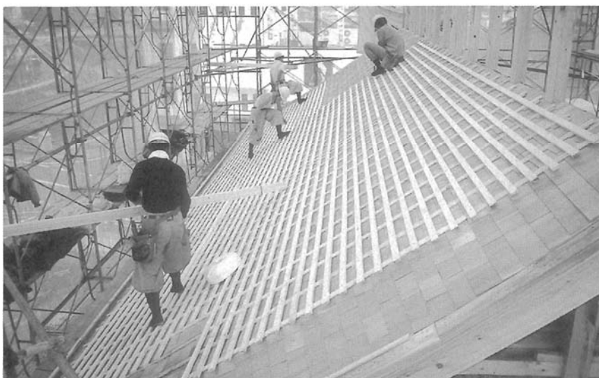
図版一39 大手門屋根瓦下地横棧打ち
