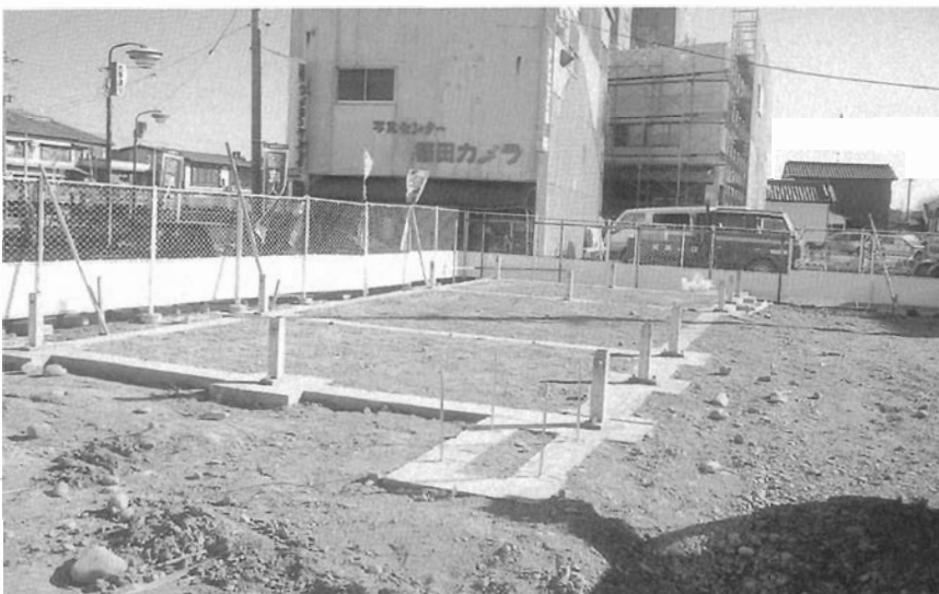
図版-25 大手門基礎柱脚固定
