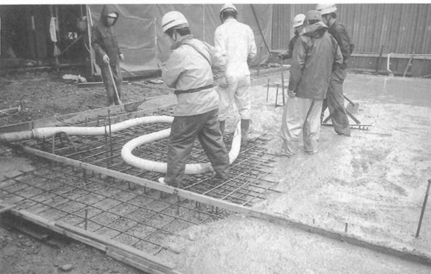
図版—67 番所コンクリート打ち
