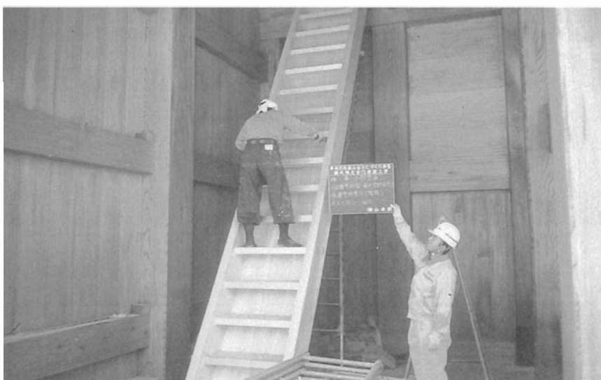
図版—52 大手門階段保護塗料塗り
