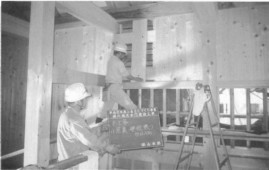
図版-36 大手門壁板貼り
