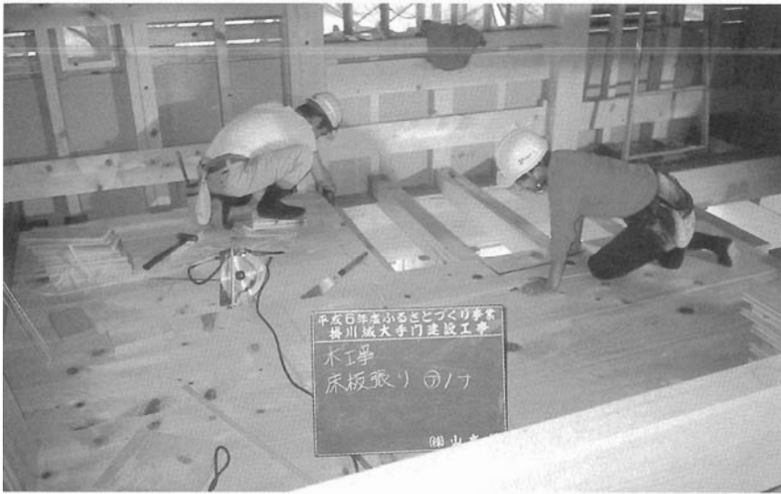
図版-35 大手門床板貼り
