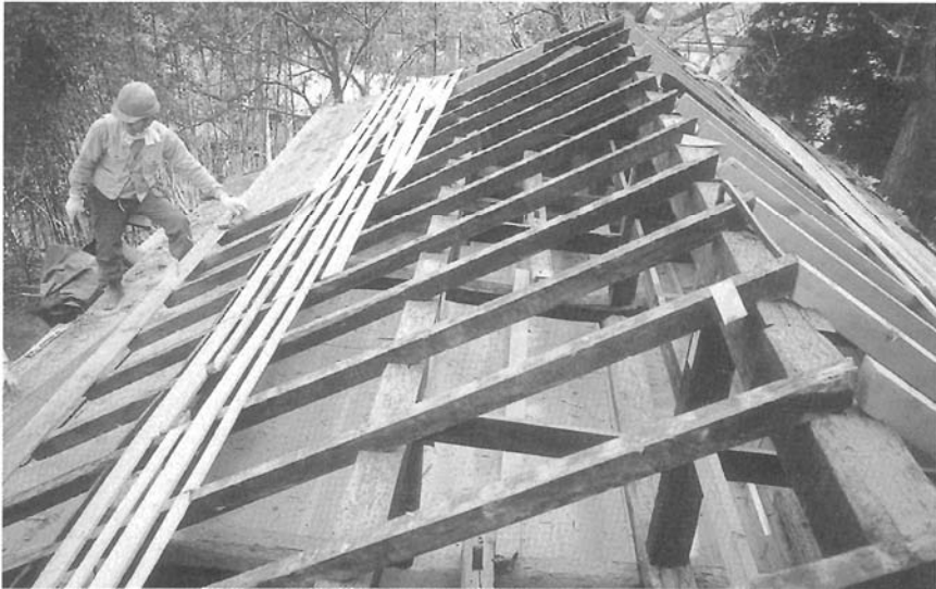
図版—60 番所解体 (小屋根)
