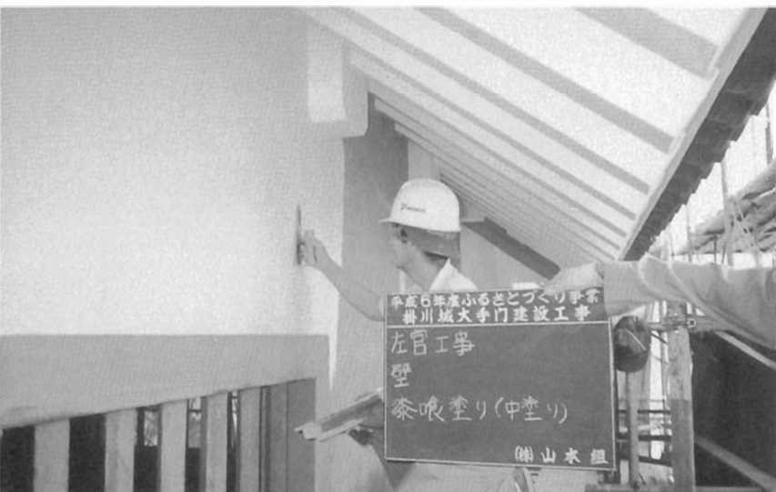
図版一49 大手門外壁漆喰塗り
