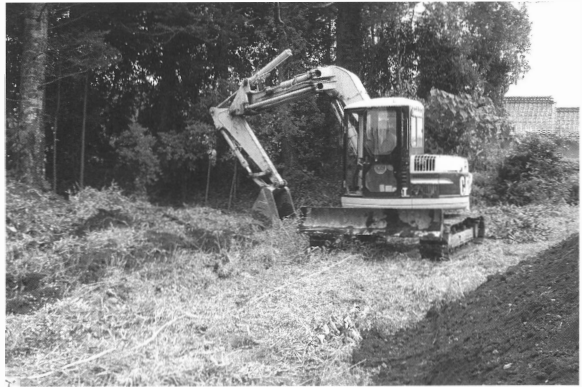
埋め戻し状況
