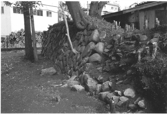
木戸石積み状況②
