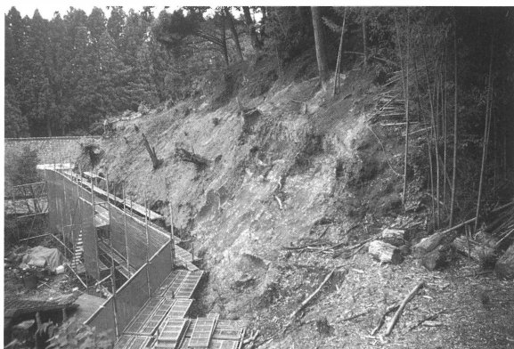
支障木伐採後状況②
