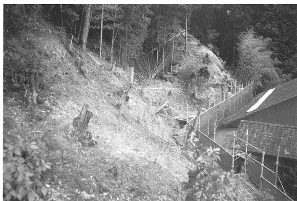
支障木伐採後状況①
