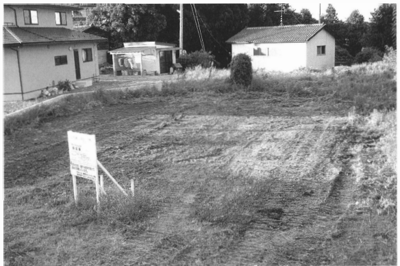
埋め戻し状況
