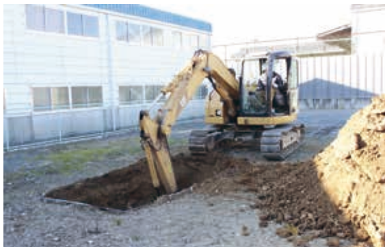
写真70 重機掘削状況
