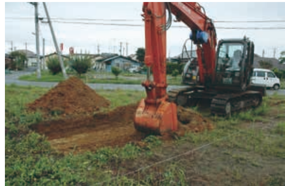
写真66 重機掘削状況
