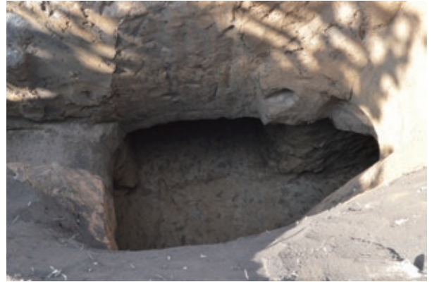
写真84 竪坑部完掘状況（南から）
