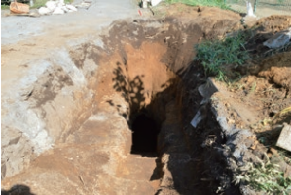
写真83 陥没付近開削状況（西から）
