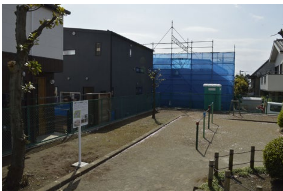
写真 89 遺跡解説板設置状況 (令和3年3月設置)
