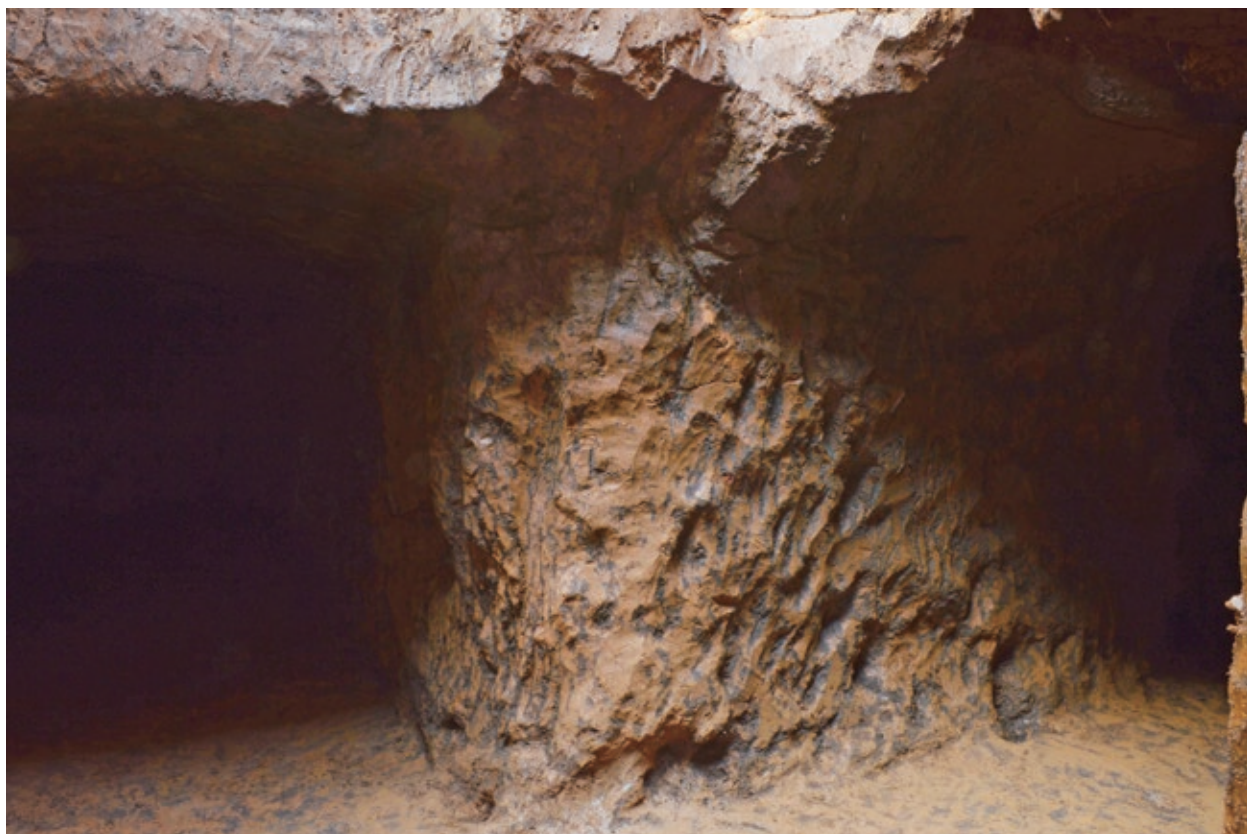
西町つつじ公園うどムロ壁面の工具痕（南西から）
