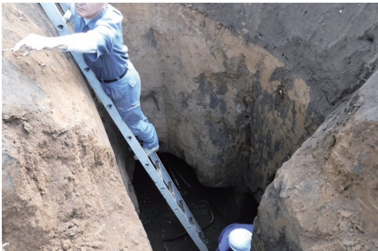
西町つつじ公園うどムロ竪坑部作業風景（北西から）
