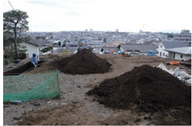
写真 68 作業風景（北から）
