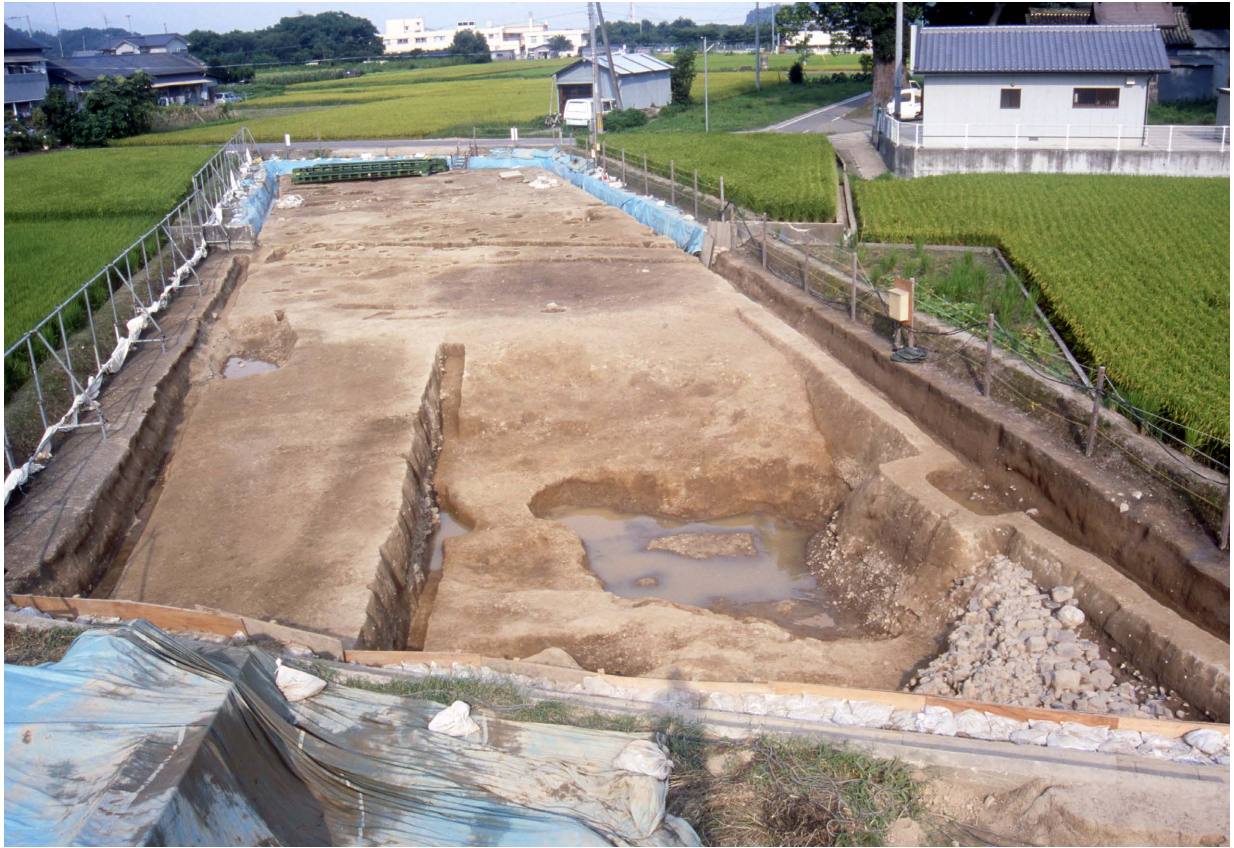
3-1 区完掘状況① (西から)
