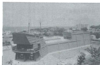
鉄砲館竣工 (昭和58年)
