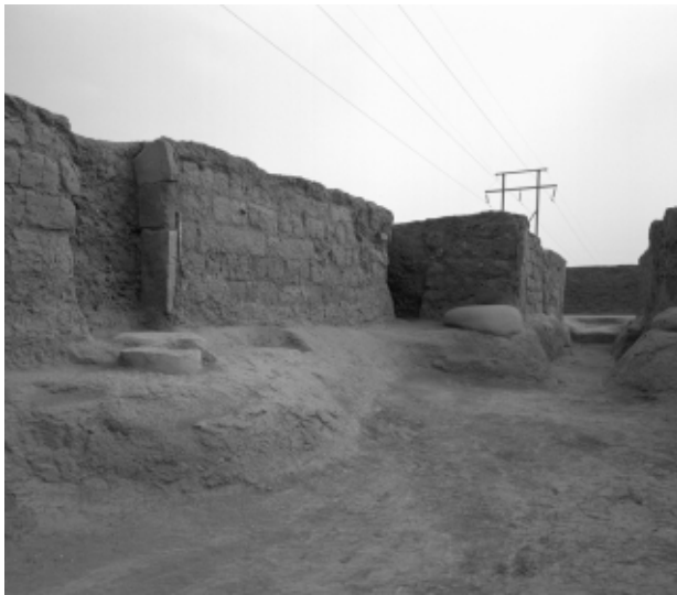
図5 地下室2の東壁(北より)
