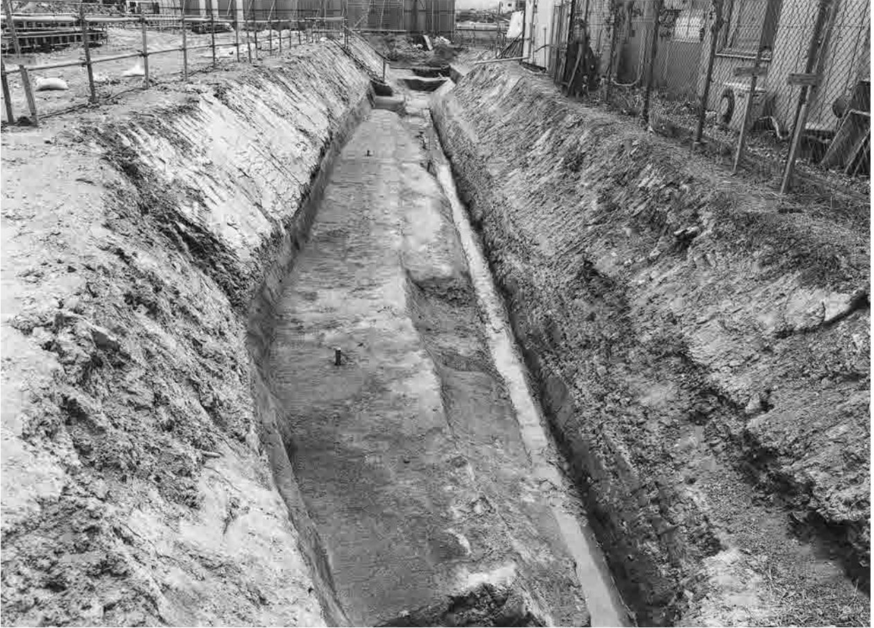
1 04-2-2 1溝全景（北から）
