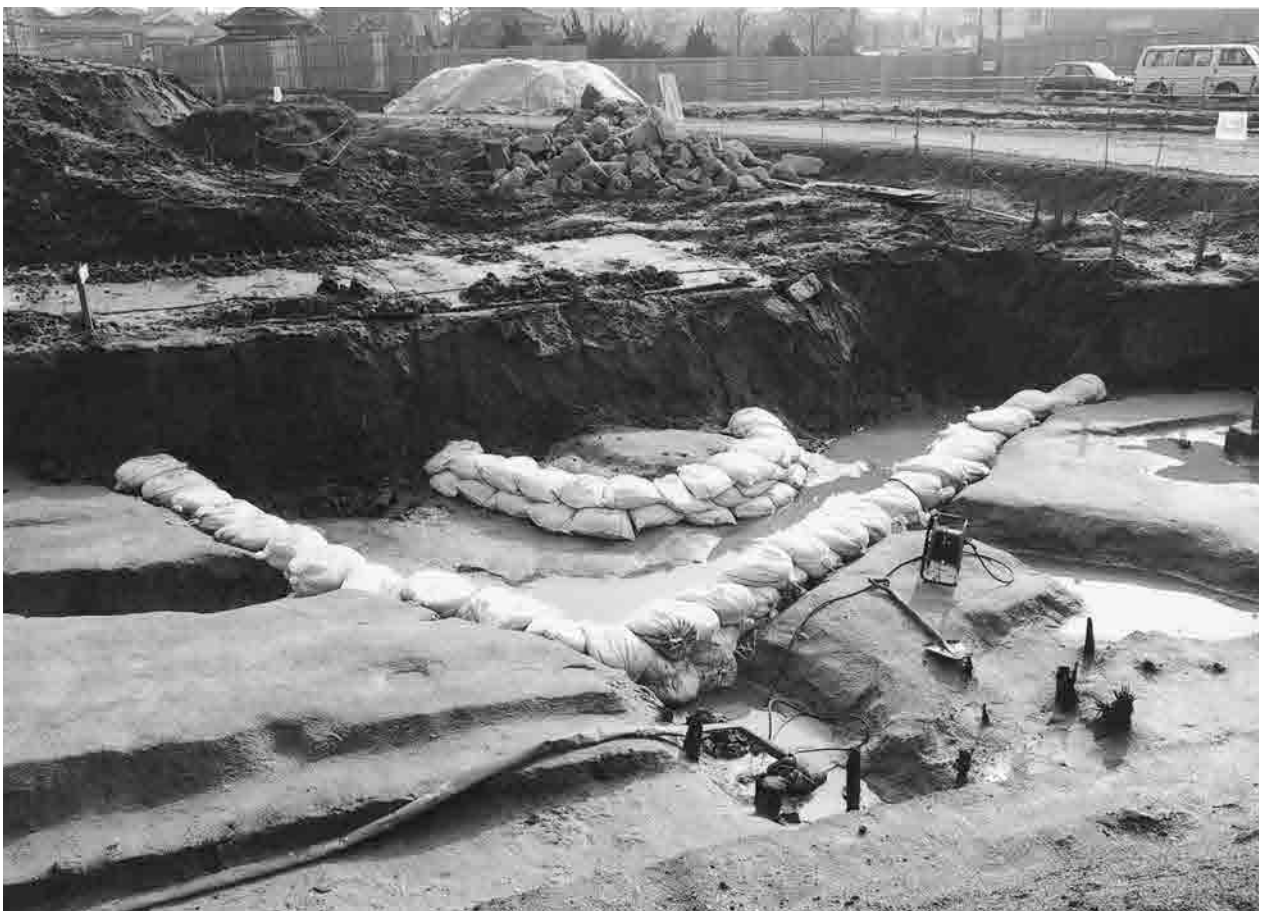
2 04-1-3 土嚢による周溝肩部の保護 (西から)
