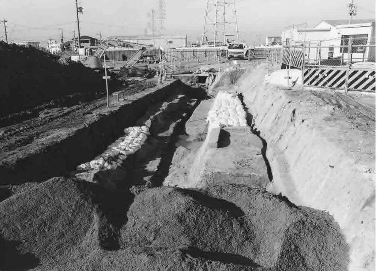
1 04-1-2 土嚢による周溝肩部の保護（東から）
