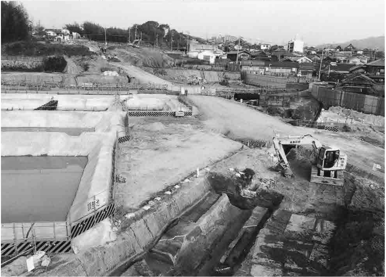
1 04-1-2 調査区から東方を望む（南西から）
