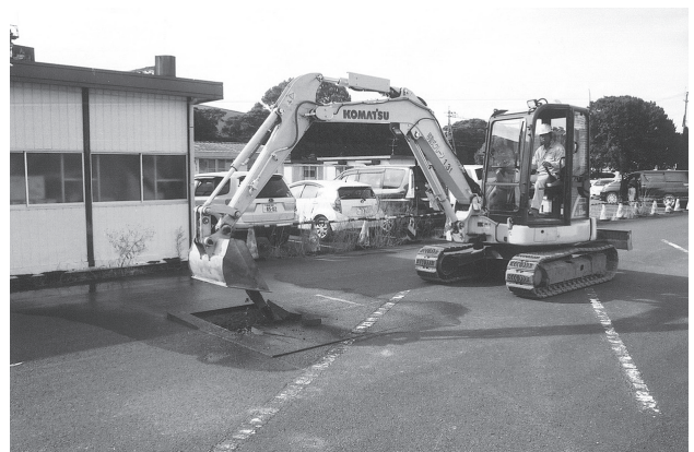
図版 6. 重機使用状況
