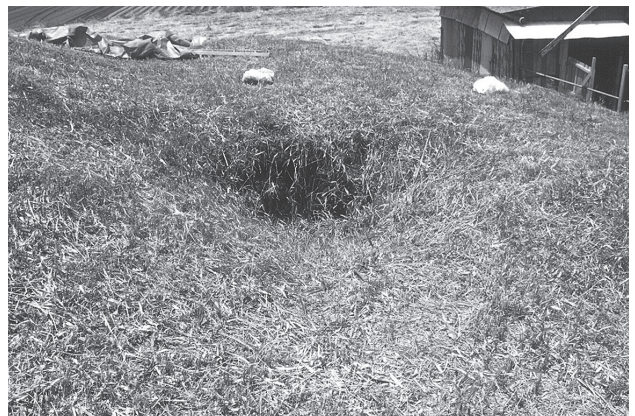
図版 6. 陥没坑確認状況 (南から)
