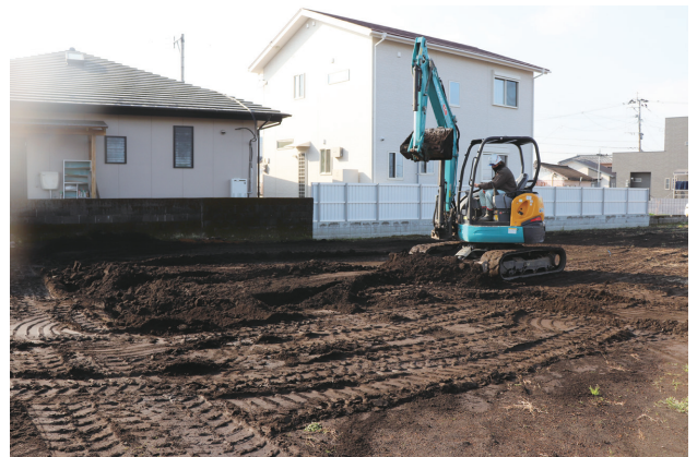
図版 16. 重機使用状況
