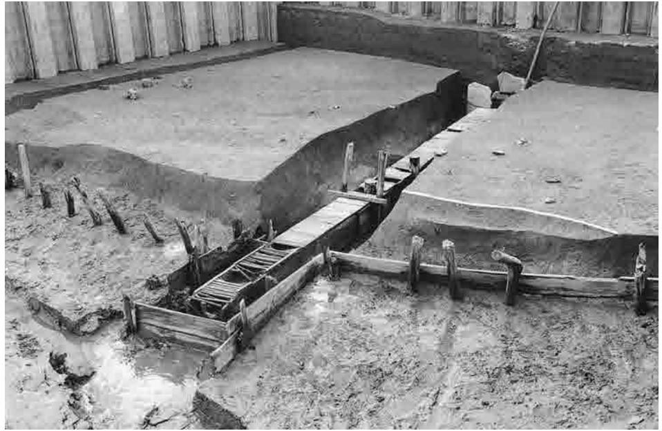
1 溜池と木樋 (北東から)
