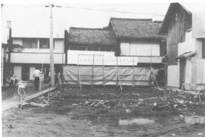
Fig. 3 四国銀行御荘支店仮店舗跡地
