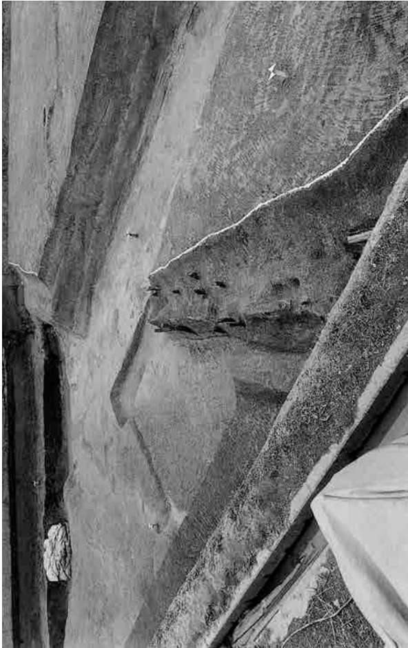
1 3流路 完掘状況 (西から)
