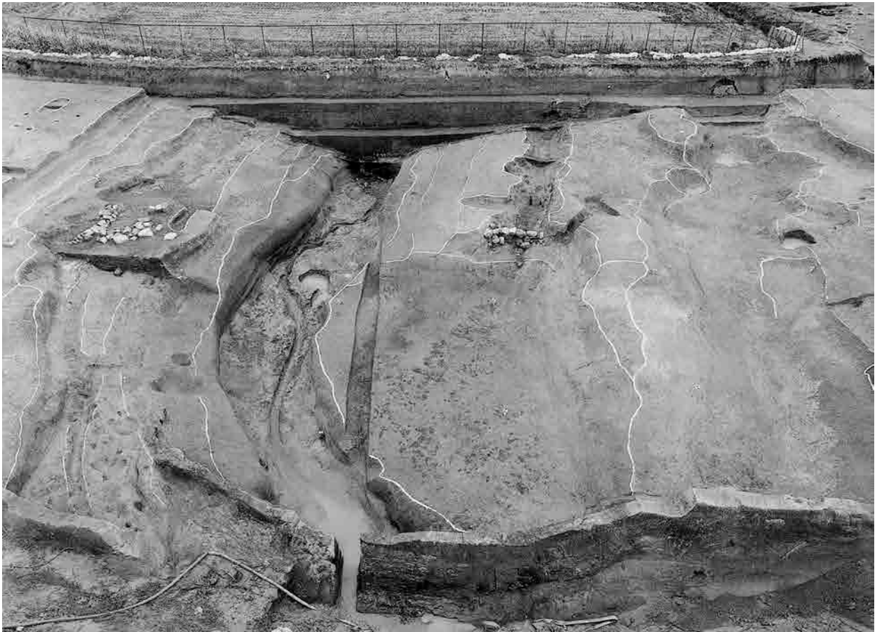
1 1大溝 完掘状況（西から）
