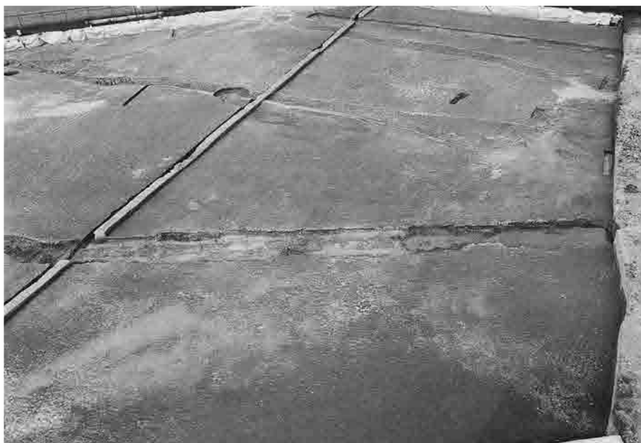
1. 7区 1面 中央部全景 (南から)
