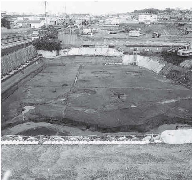
2 第6-1a層下面 全景（南から）：3-2区
