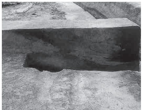
7 土坑状変形 断面(北東から)
