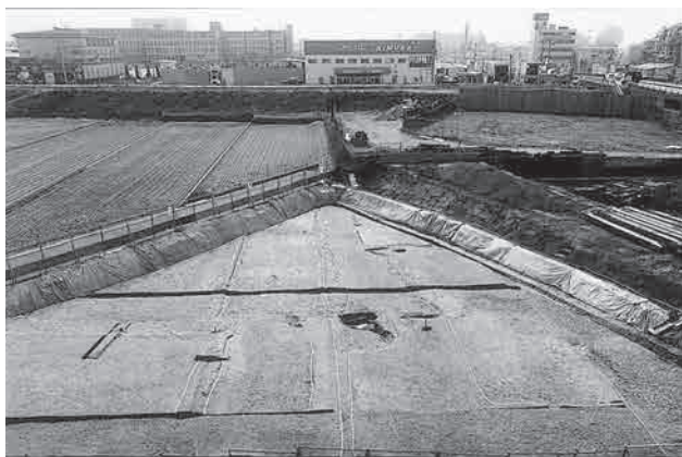
3 第1-4面 全景（北から）：3-1区
