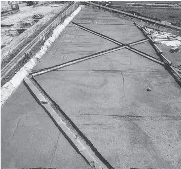
2 第4-2面北側 全景（西から）：6区
