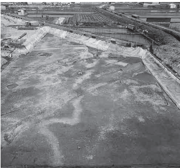
3 第6-1a層下面 全景（西から）：5区
