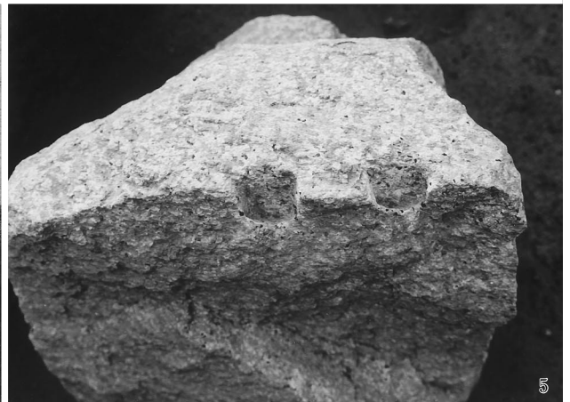
4. 側壁石材に残る楔痕跡
