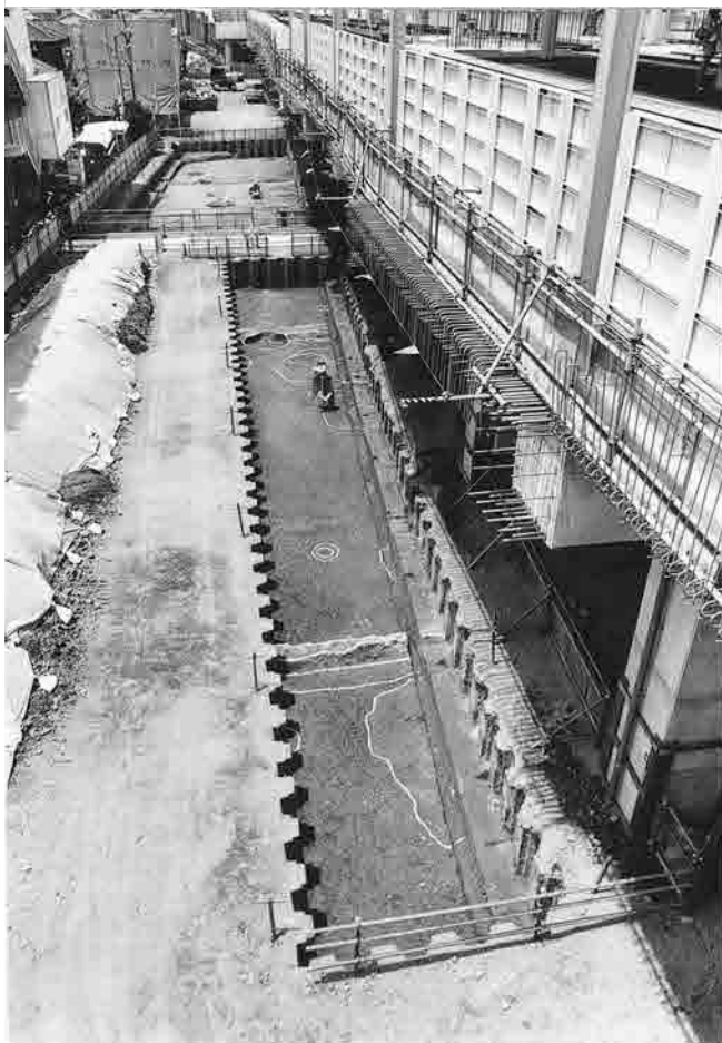
c 4区全景東から
