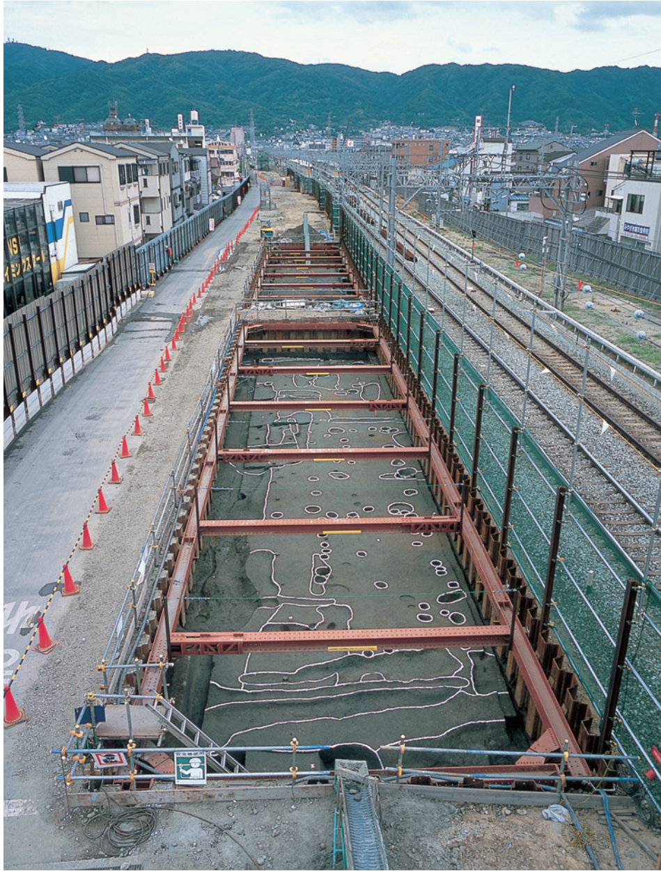
1. 06-2-2 調査区第3面全景 (西より)
