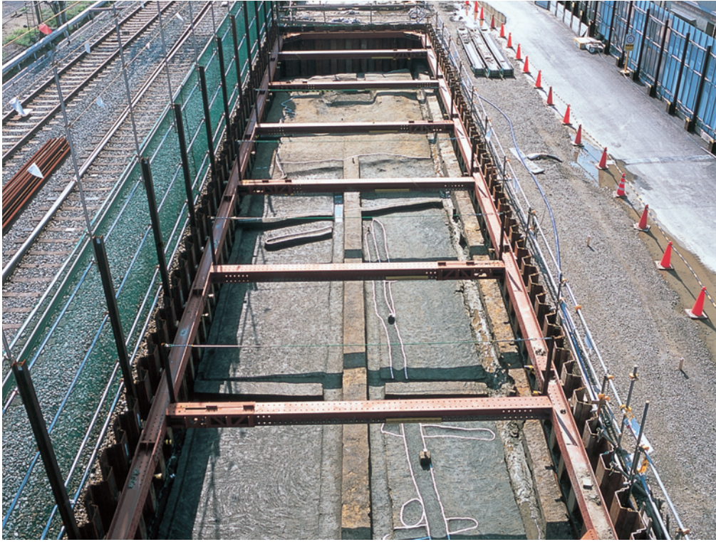
2. 06-2-1 調査区 第3面全景 (東より)
