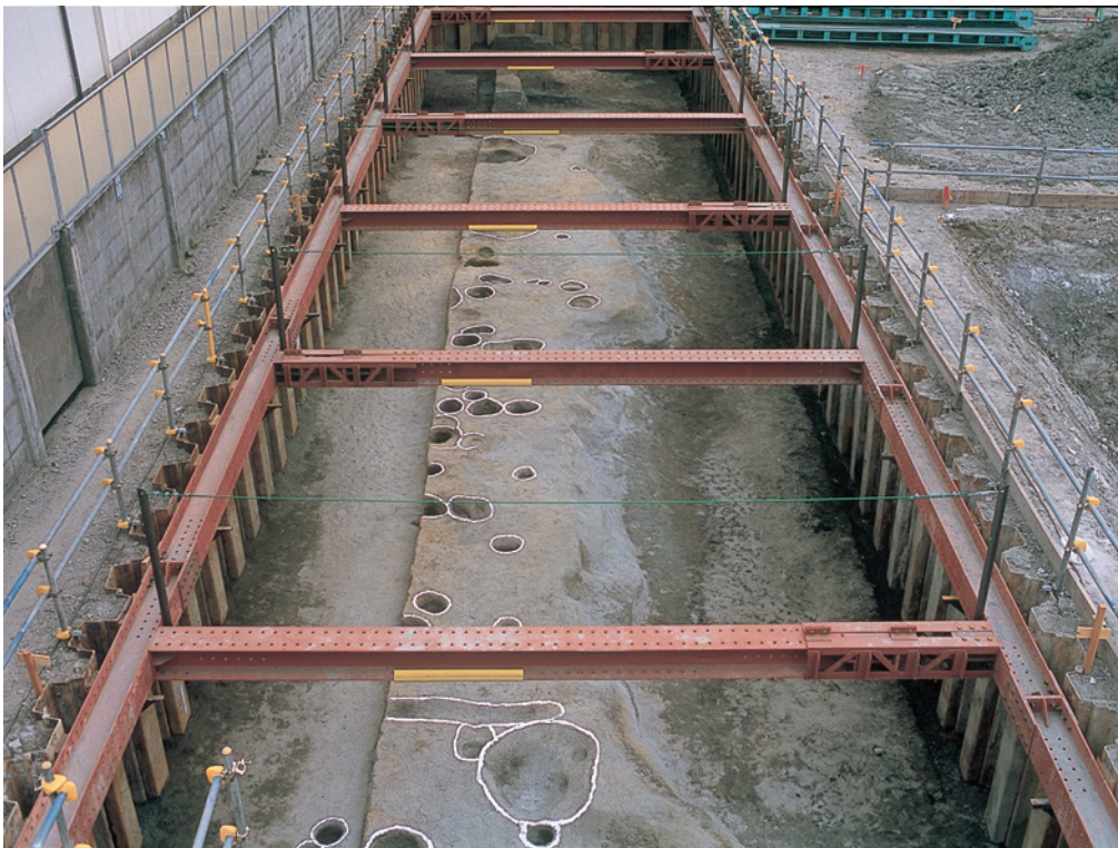
3. 06-2-3 調査区 第1-2面全景 (東より)
