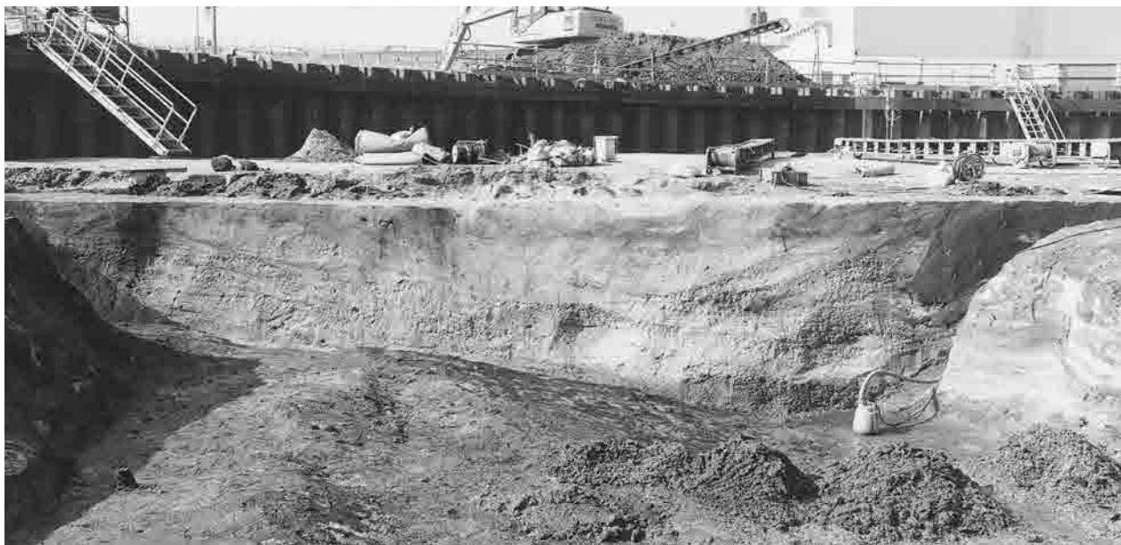
第6面252大溝横断面 (東から)
