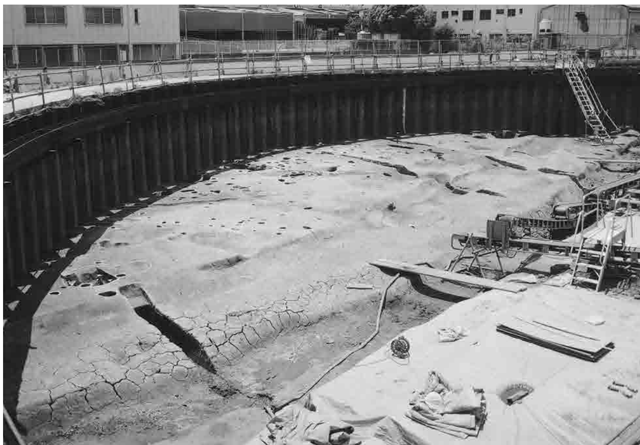
第10-2面南高台 (北東から)
