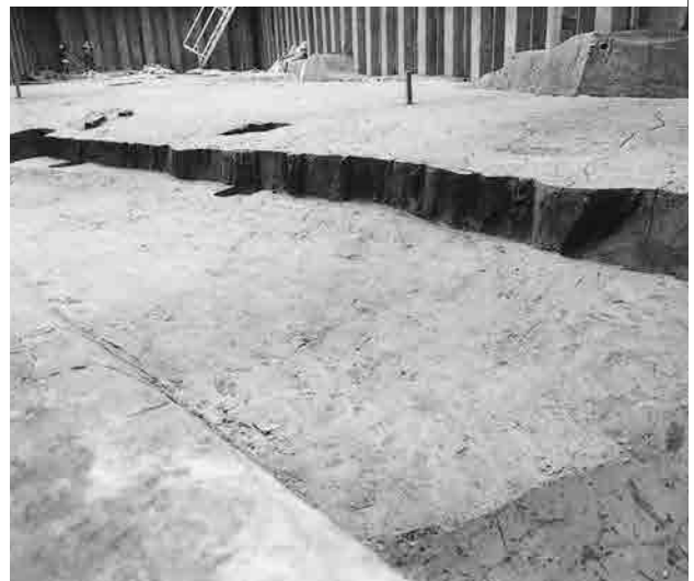
第11面1421矢板断ち割り (東から)
