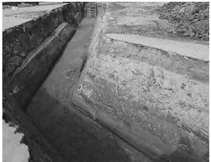
調査終了面 (南東から)
