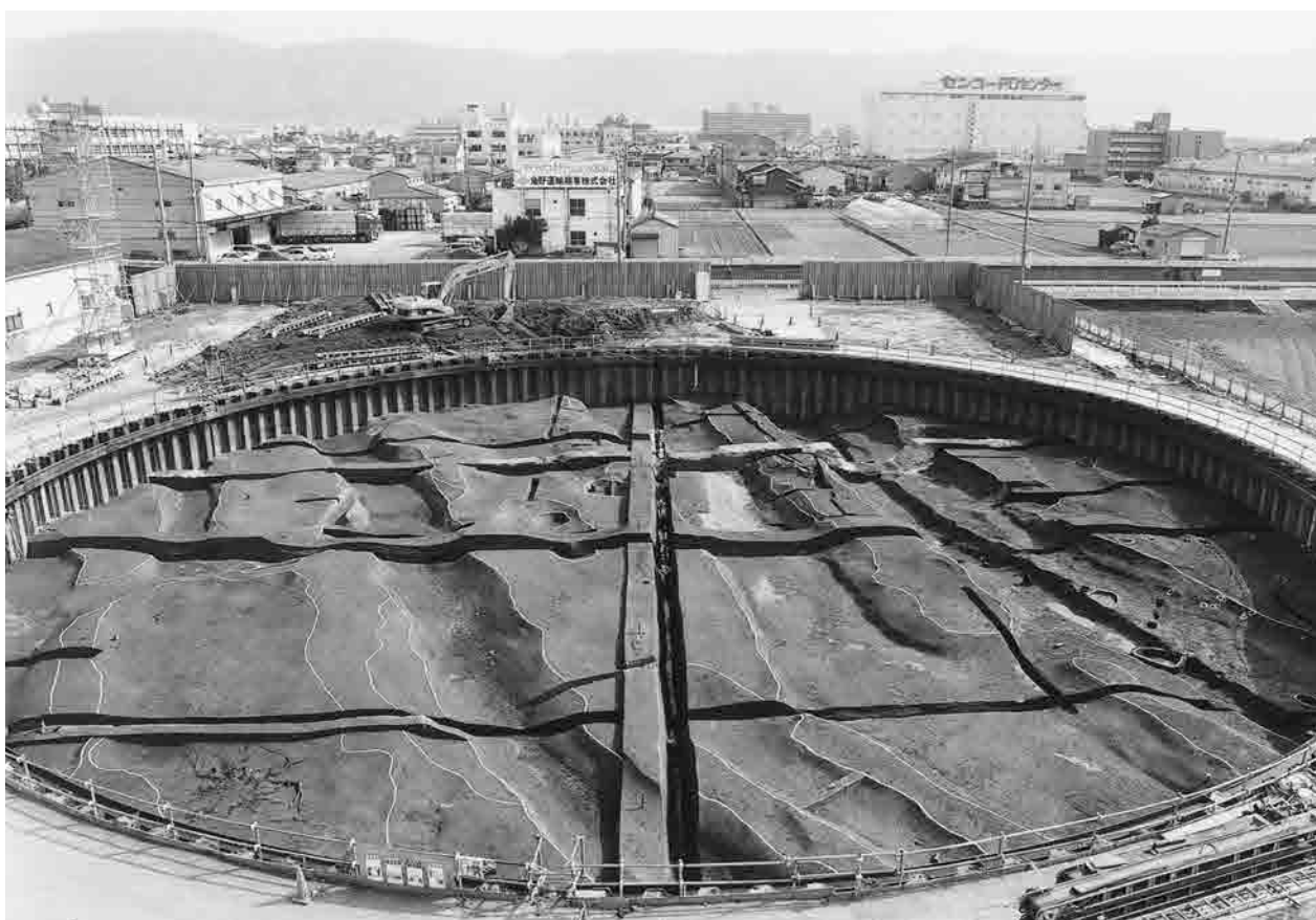
第8面全景 (西から)
