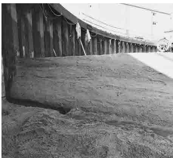
第6面252大溝縦断面西側 (南東から)
