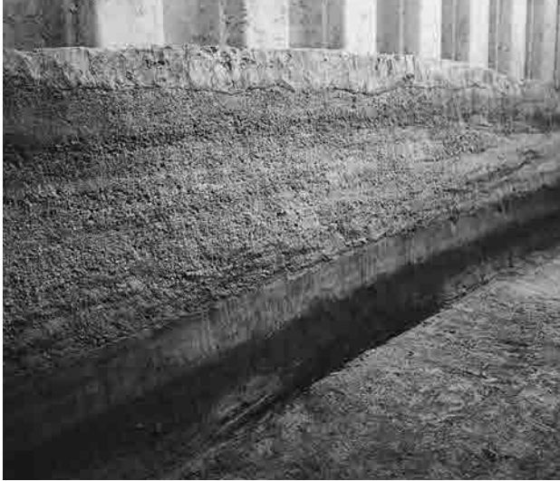
東辺第0～4層断面(北西から)
