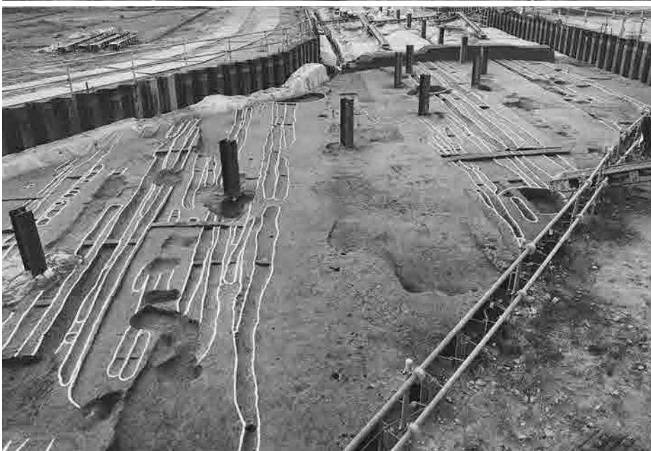
3 1 調査区 第3面中央 検出状況 東から
