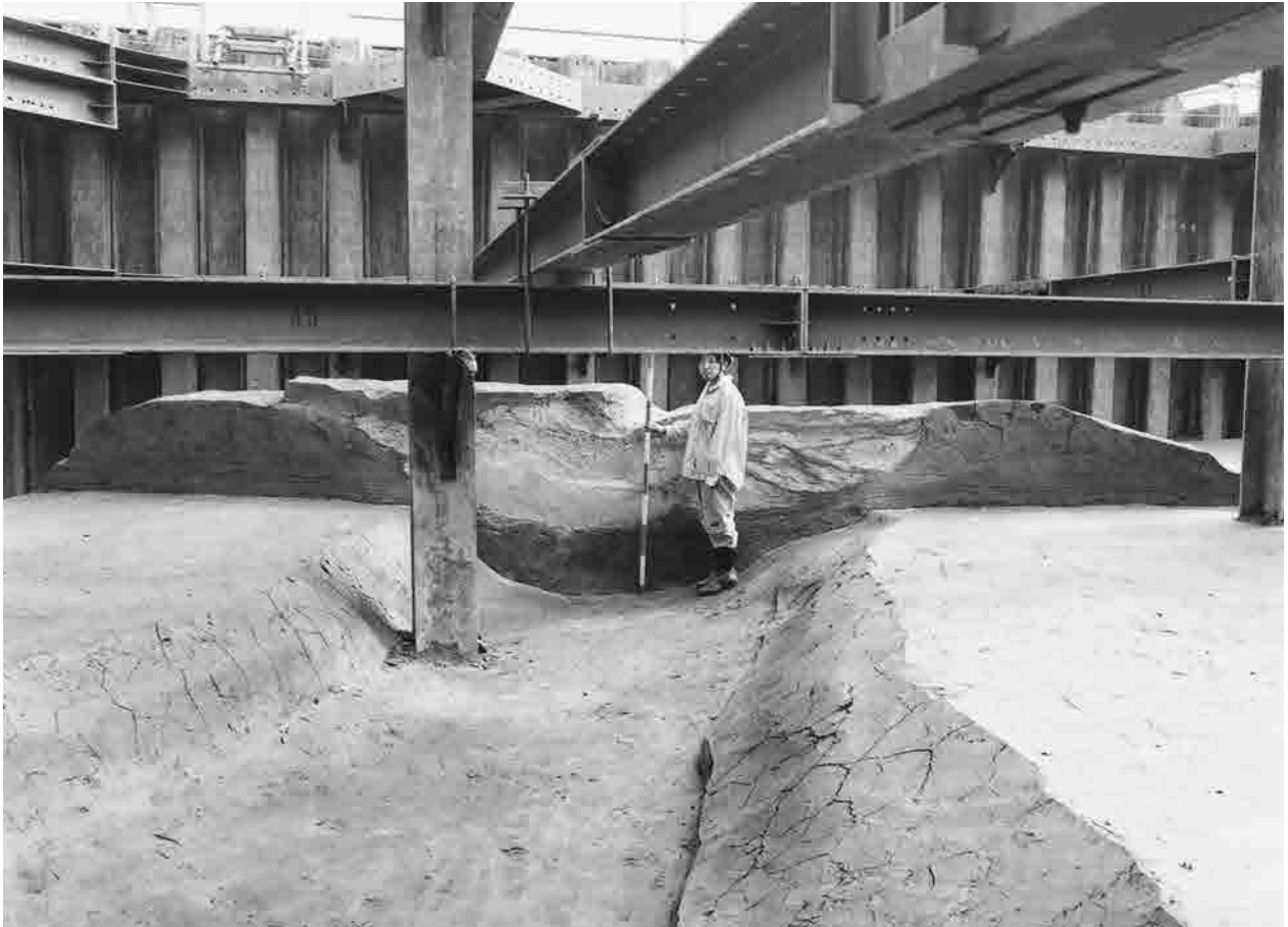
1 2調査区 2-131溝・132・134高まり 断面 北から
