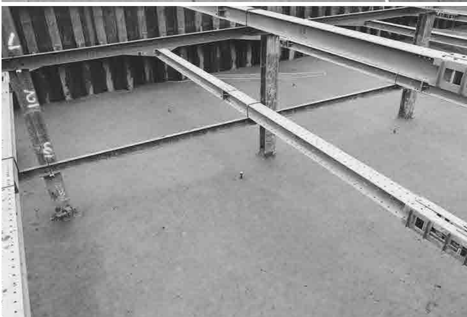
3 1調査区 第15面 検出状況 南から
