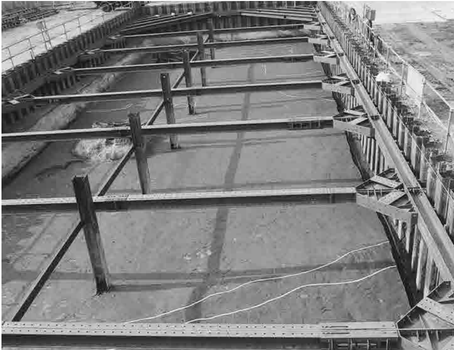
1 1調査区 第8面西半 検出状況 東から
