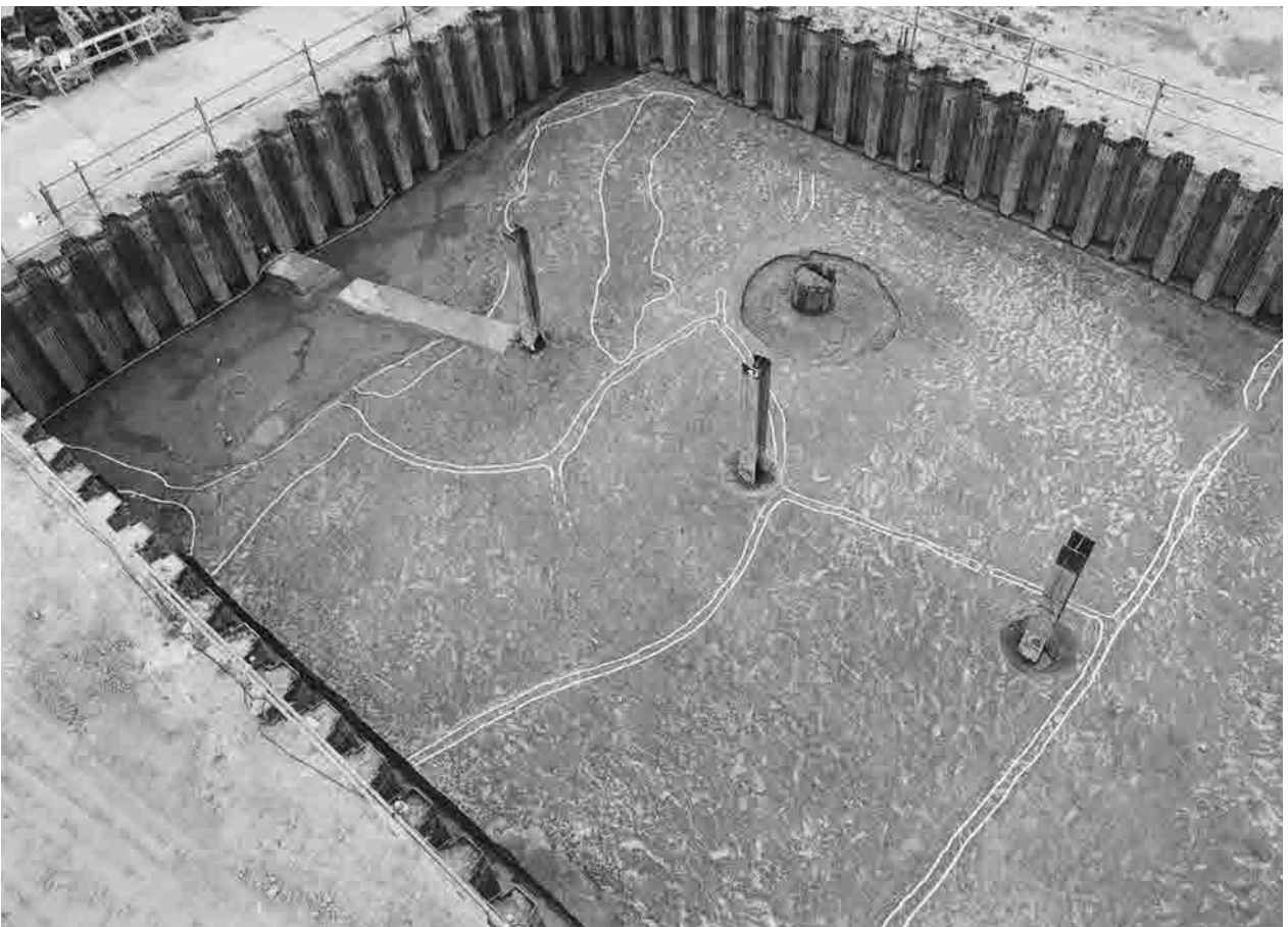
2 3 調査区 第 7 面 検出状況 北西から
