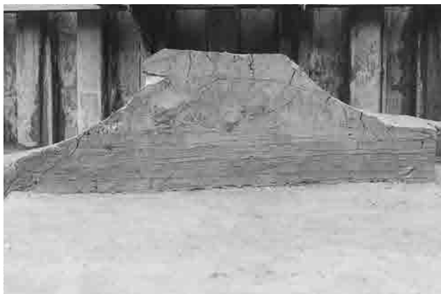
6 1調査区 1-406高まり 断面 南西から
