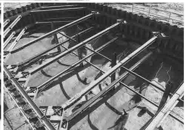
4 1調査区 大溝群 北から
