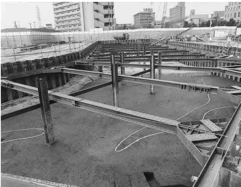
2 1調査区 第8面中央 検出状況 東から
