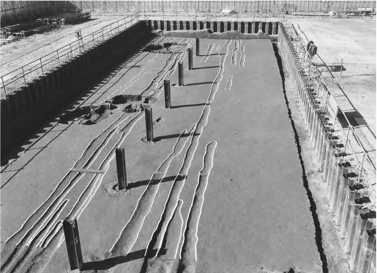
1 1調査区 第4面西半 検出状況 東から
