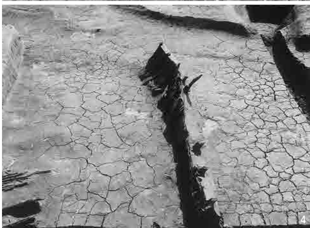
2. 4区 第3面 663堤F区下部構造近景1（南東から） 4. 4区 第3面 663堤F区西端杭列（北東から）
