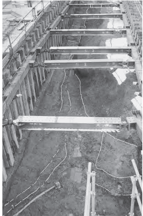
4. 4トレンチ段丘崖 斜面堆積完掘状況 (北東から)
