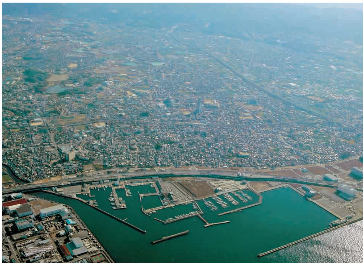
1. 調査地遠景（北西から）
