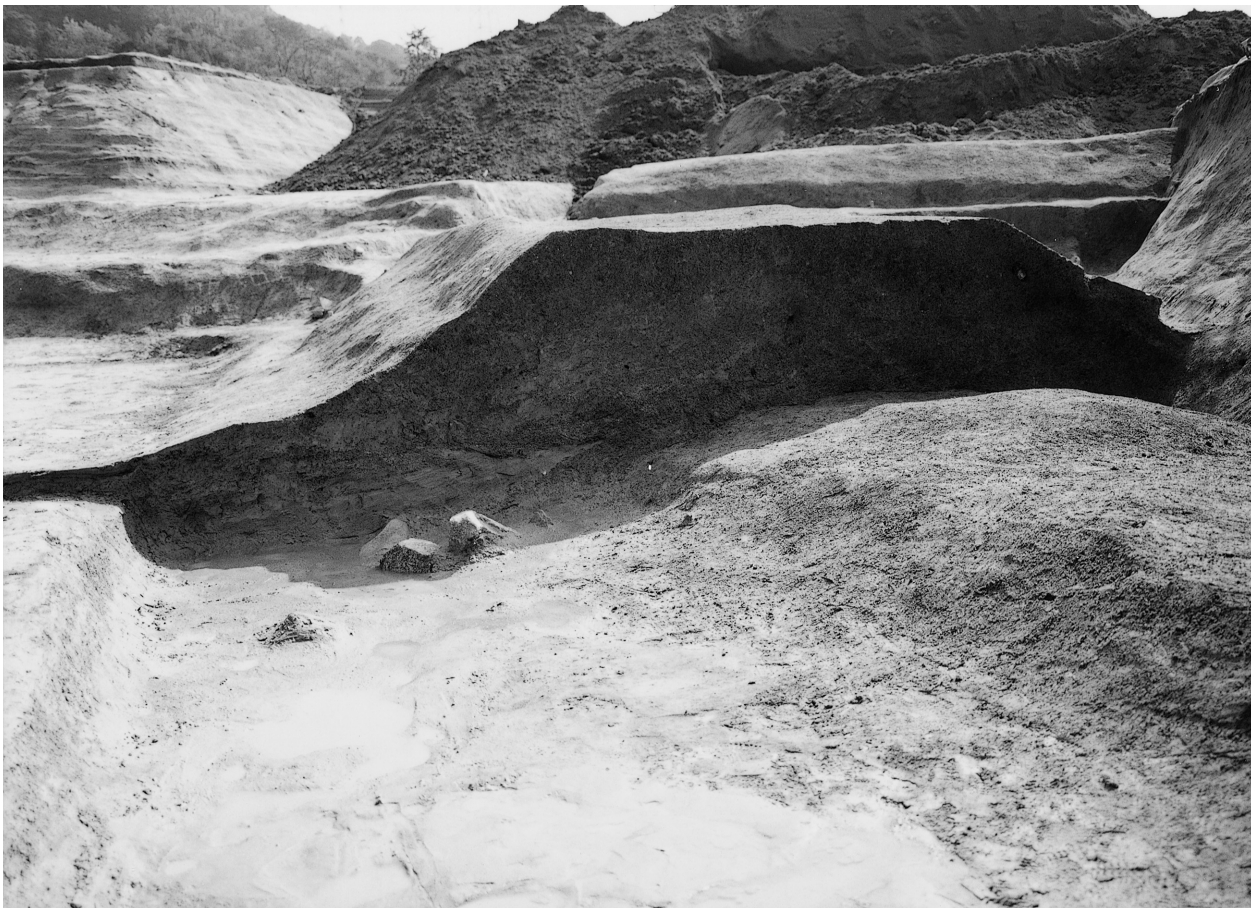
2 255堤防新段階断面（北から）
