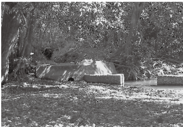
写真1 井堰 (取水口が左側に見える)
