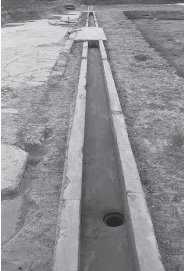
写真 128 10区(A1棟)第1面1建物北辺側溝(東から)
