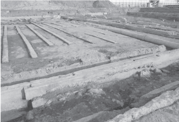
写真 253 12区第1面2建物西出入口(北西から)
