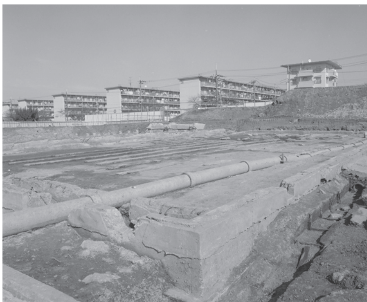
写真 250 12区第1・2面2建物(南西から)
