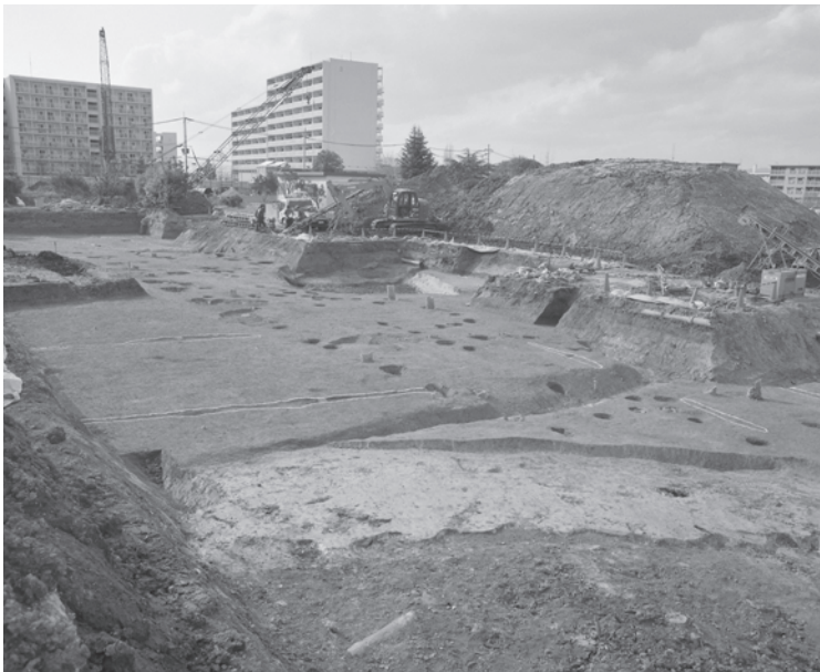
写真 146 10区(A1棟)第3面(南東から)
