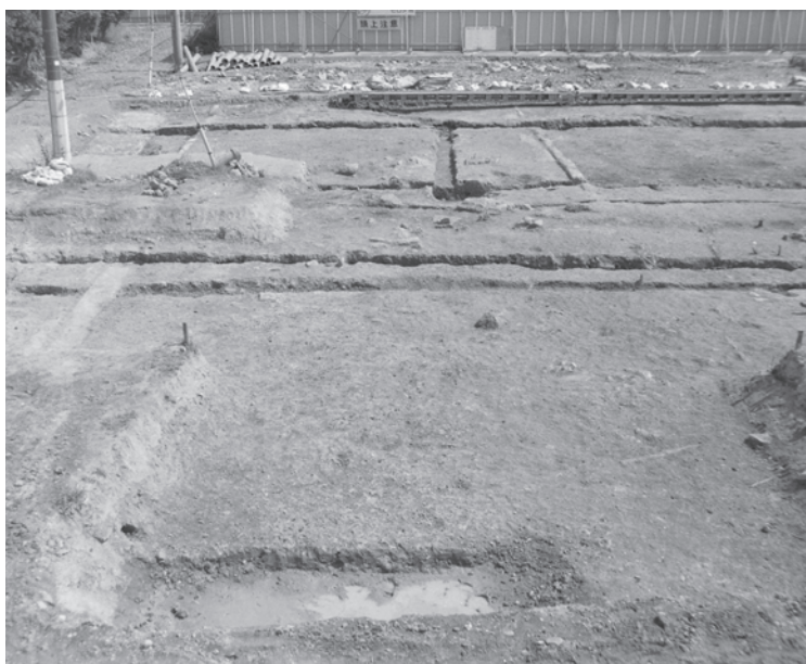
写真 197 11区第2面東部(北から)
