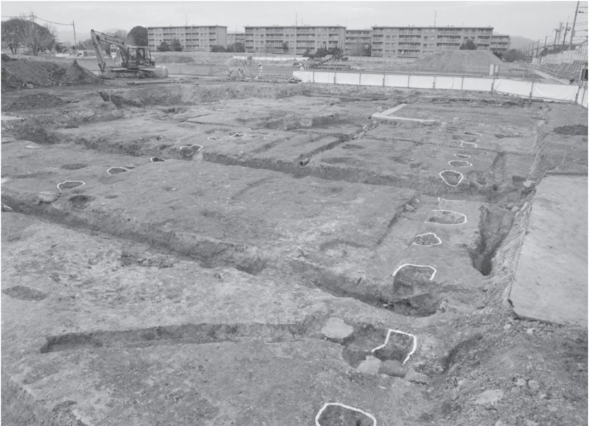
写真133 10区(A2棟)第2面(南東から)
