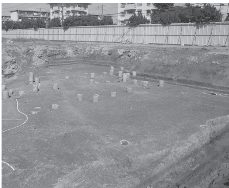
写真100 9区第5面(南西から)
