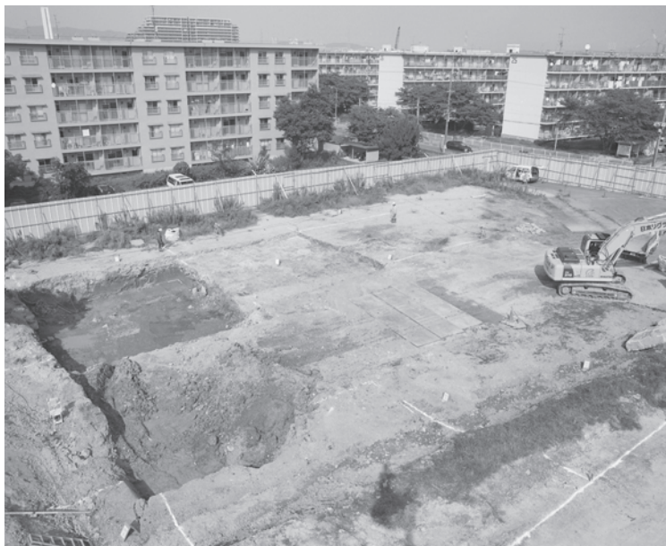
写真5 2区・3区・4区 機械掘削状況 (南西から)
