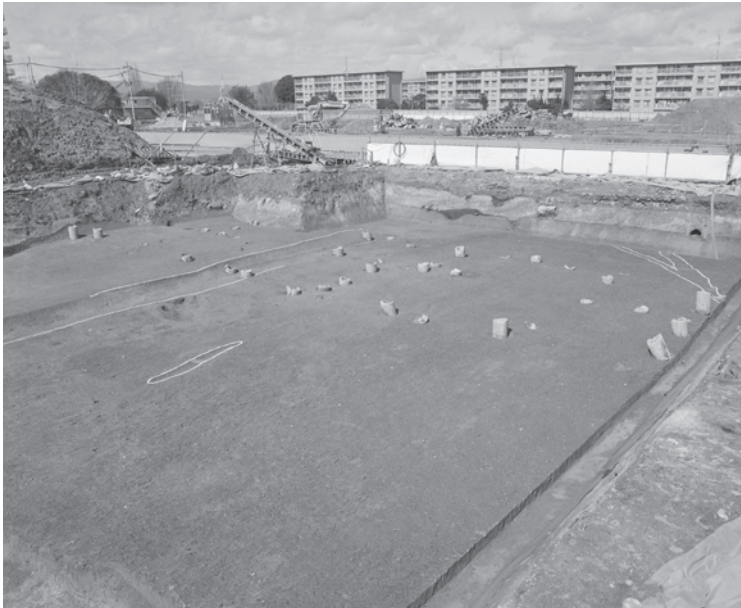
写真 145 10区(A2棟)第3面(南東から)
