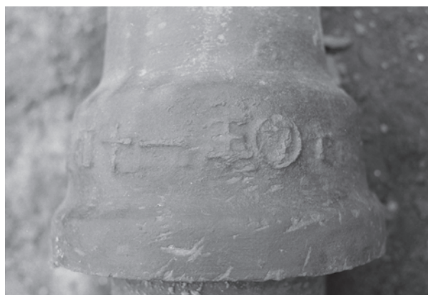
写真 215 11区第3面238鉄管溝の昭和11年銘(2)
