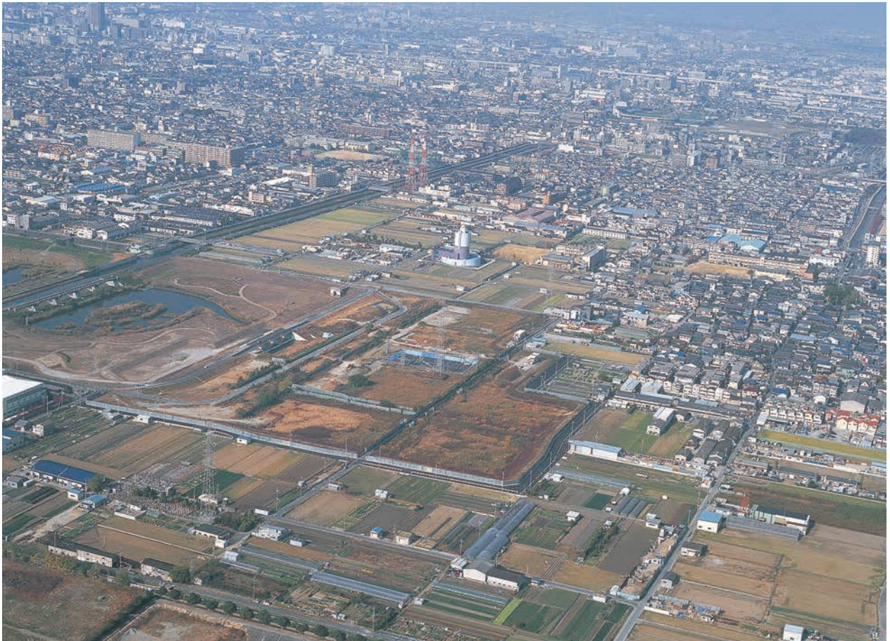
調査地遠景（南東から）
