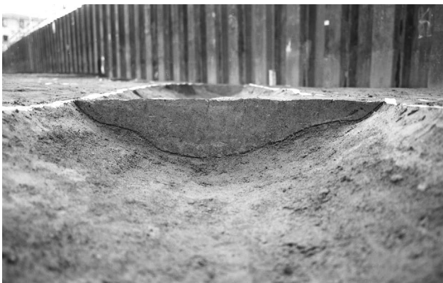
903溝 断面 北西から
