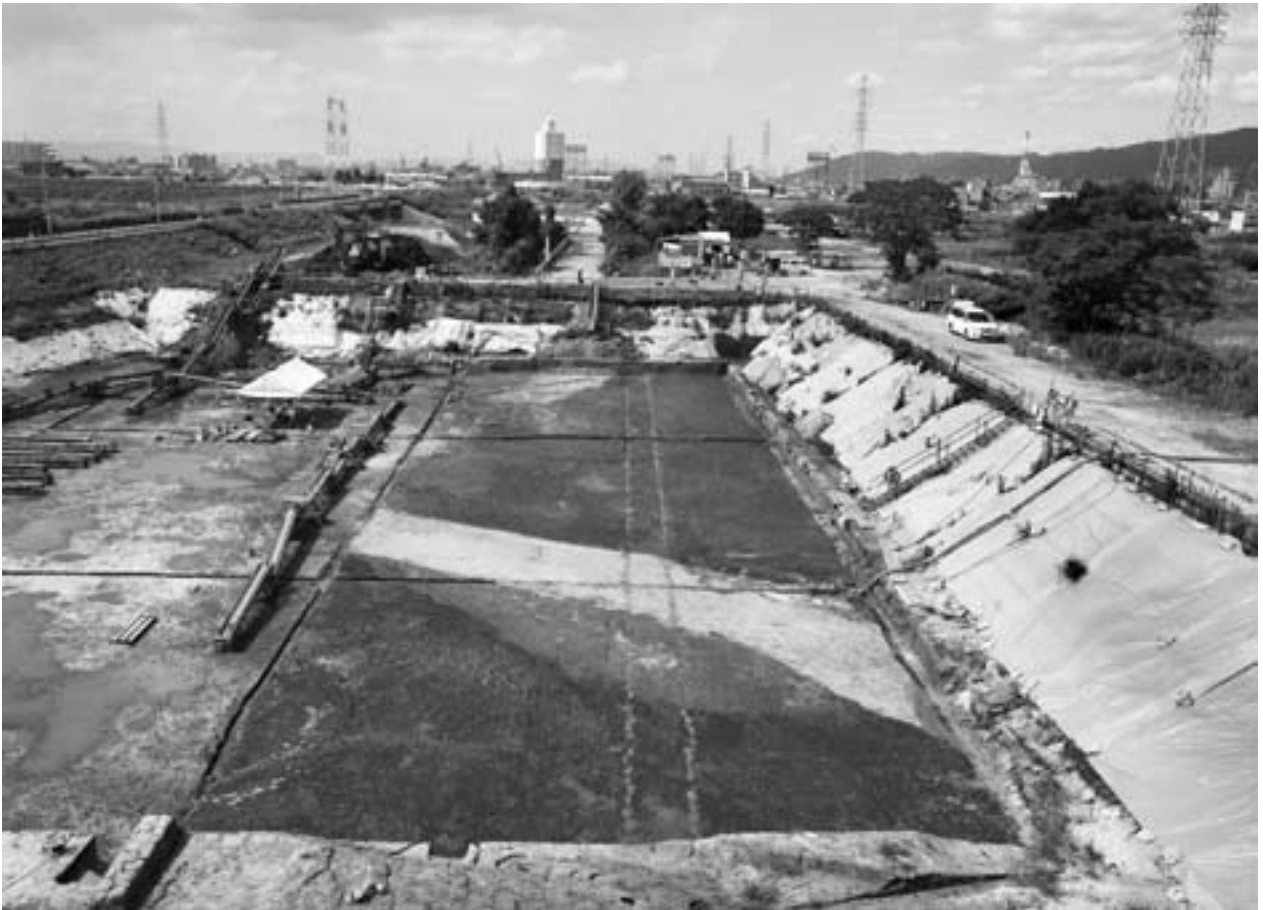
2 第15-2面 東半部全景 (南から)
