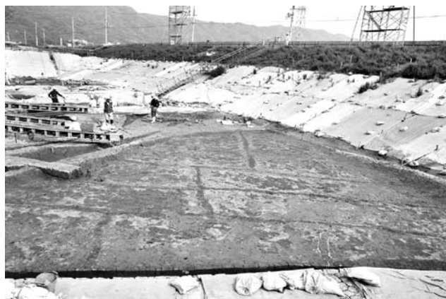
写真 25 第14-2面 畦畔検出状況（西から）
