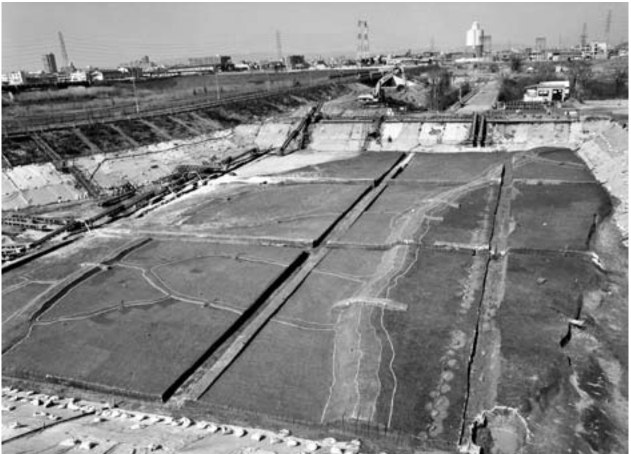
2 第12面 東側全景（南東から）
