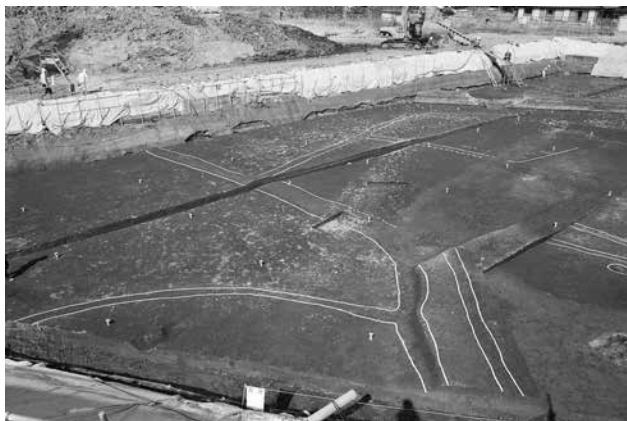
1. 1-295、1-296 畦畔 (南東から)
