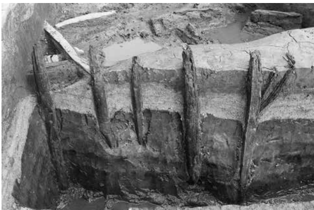
5. 1-60 溝 杭列 2 断割り状況 (西から)
