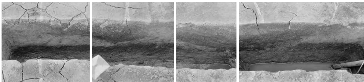
7. 第 8b-3 面 土坑状変形 1 断面 (南西から)
