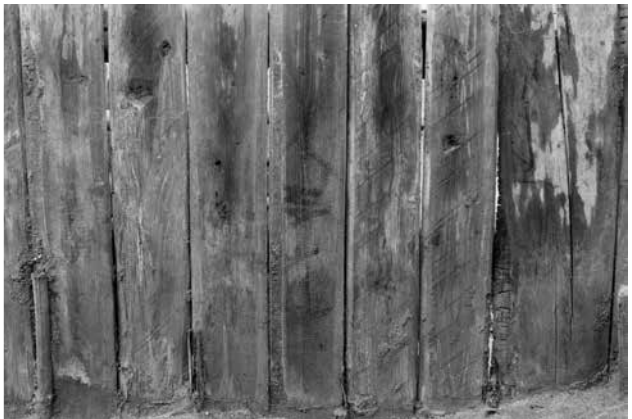
8. 5-6 溜め井 (東から)
