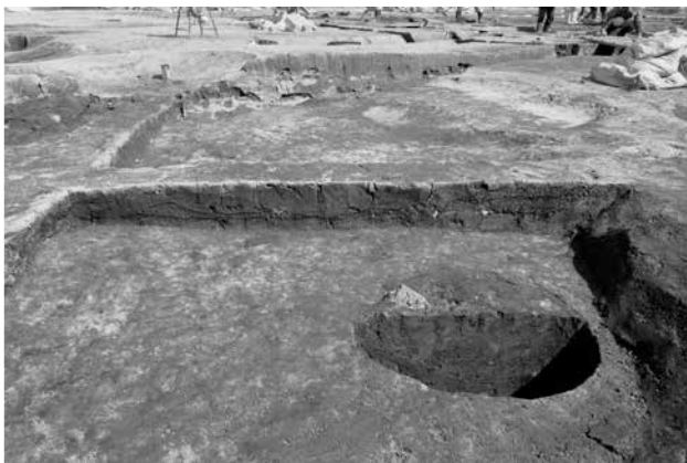
8. 建物 17 Aライン断面東半 (南西から)
