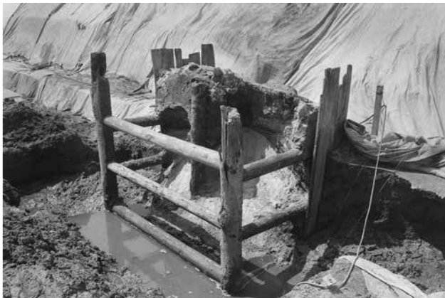
2. 第1面 6-120 井戸 側板除去後 (南東から)
