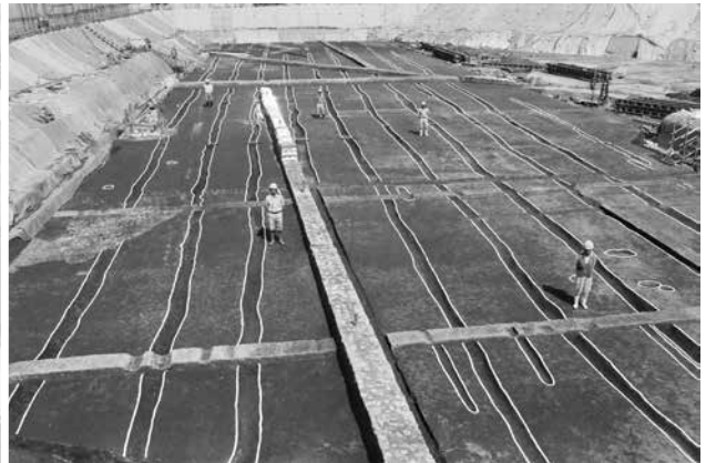
4. 小溝群 (西から)
