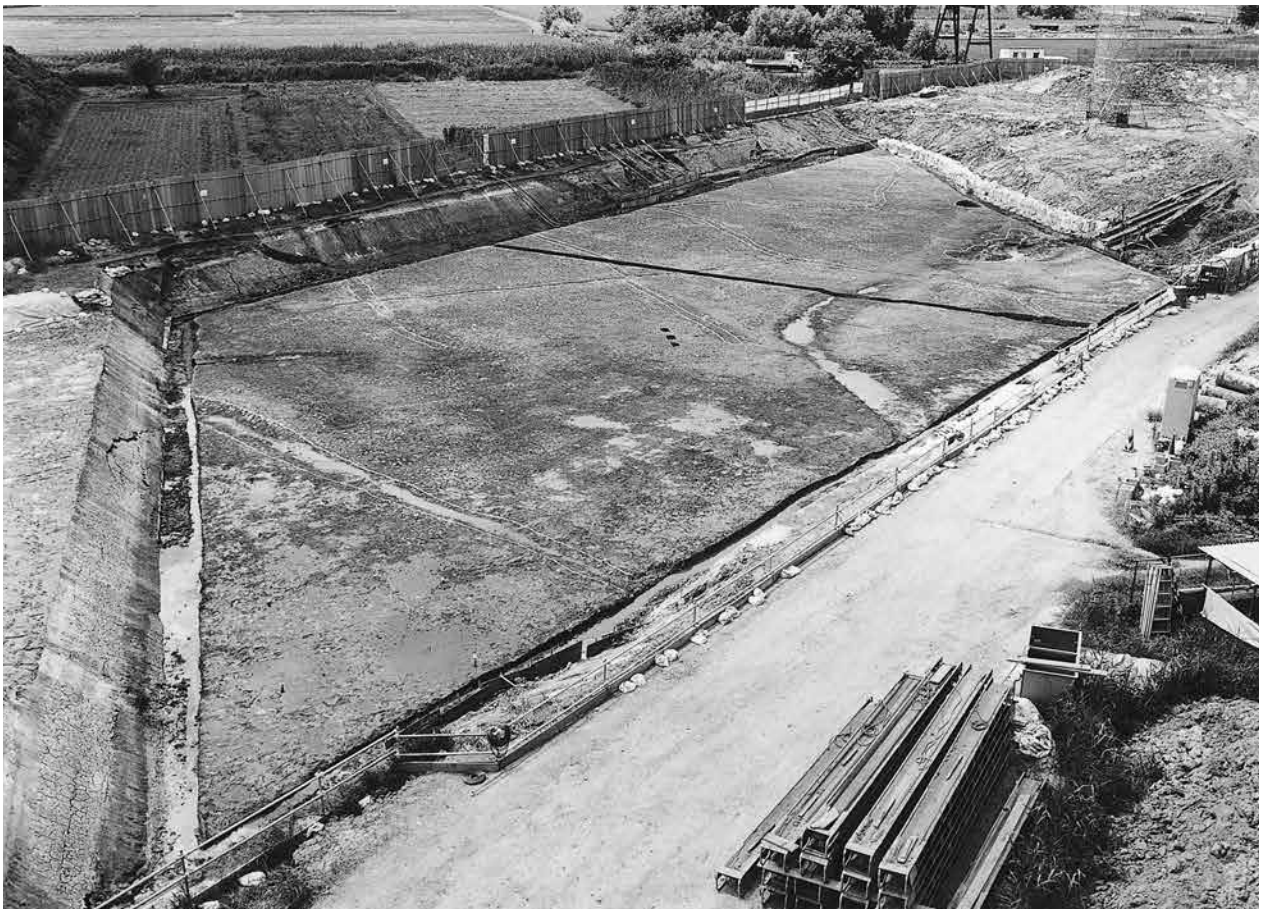
(2) 第2-3面 (03-5-4トレンチ 北から)
