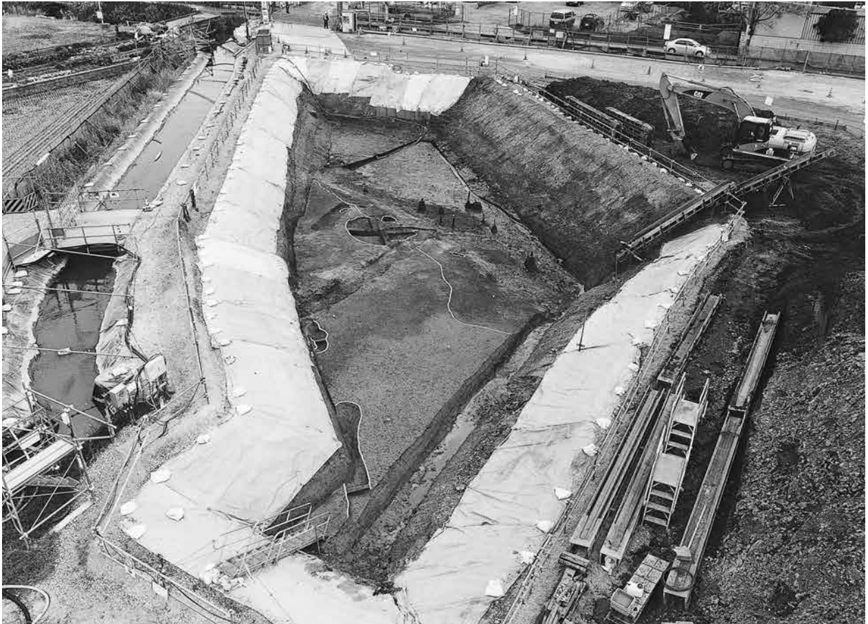
(1) 第1面 微高地3 (06-2-3トレンチ 東北から)
