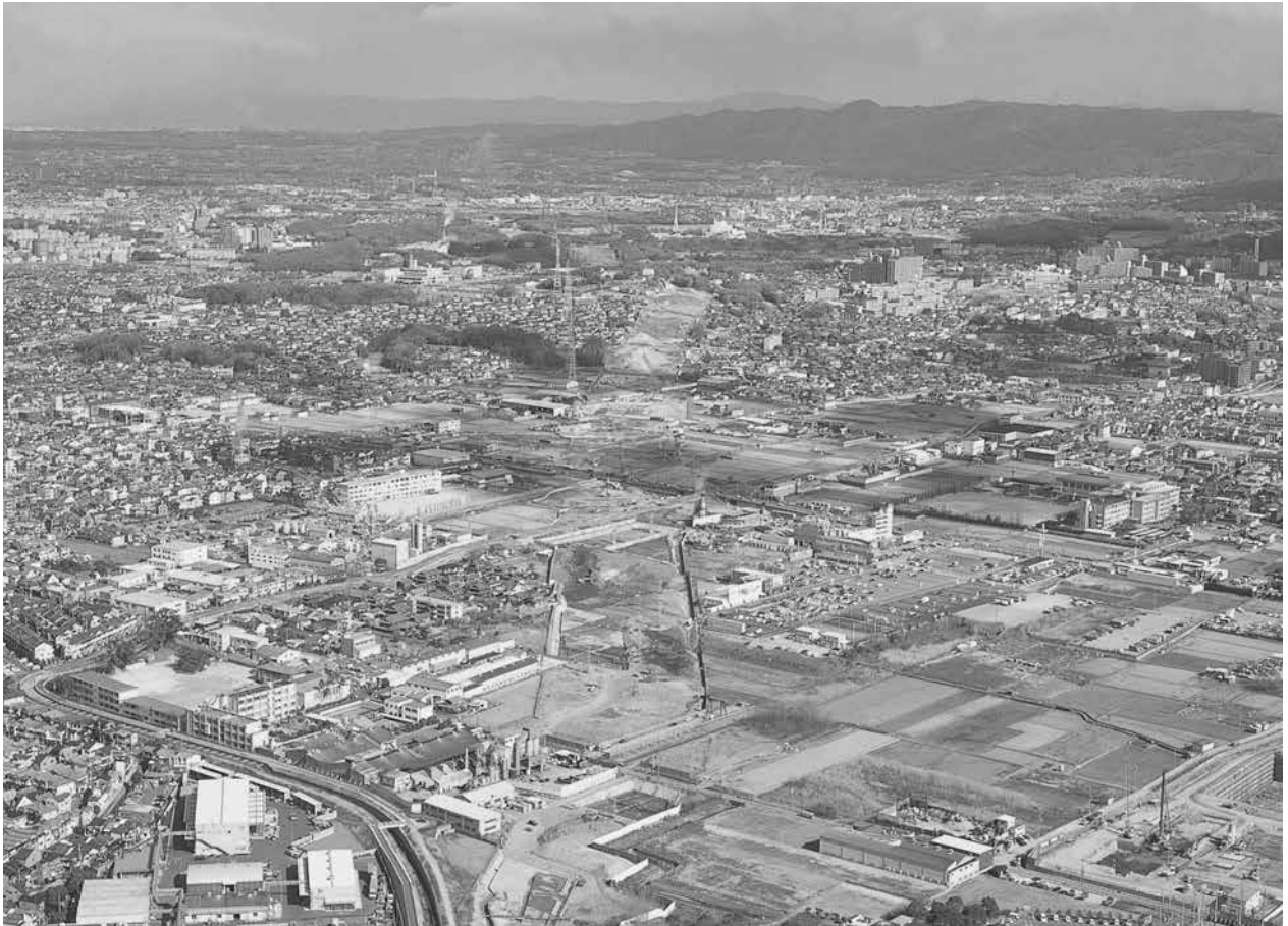
(1) 調査地遠景 (南西から)
