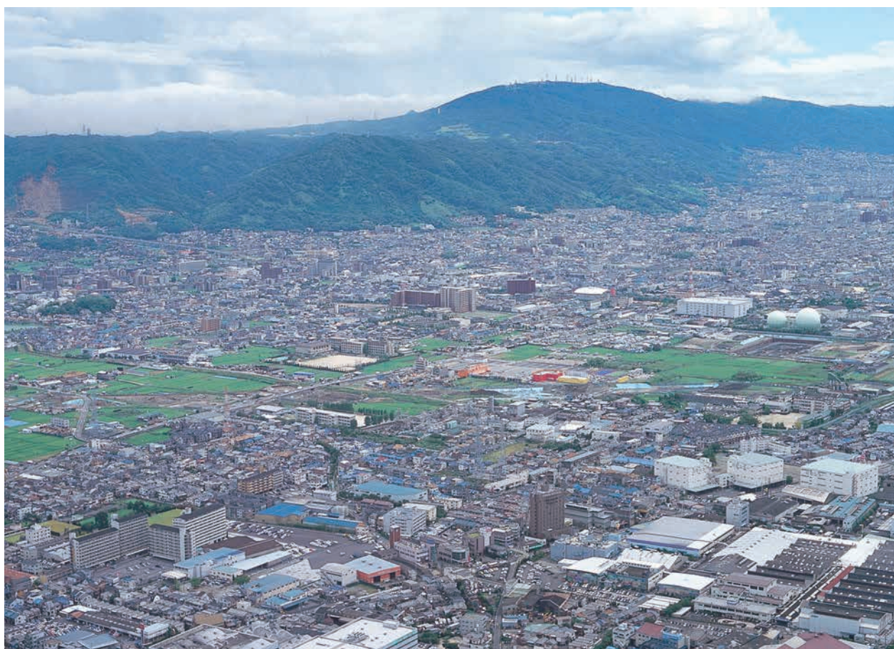
(2) 調査地遠景 (北西から)
