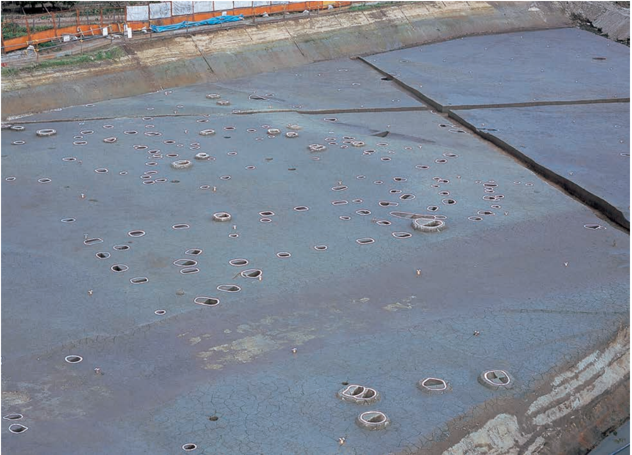
(1) 第1面微高地1 (03-5-6トレンチ 南から)
