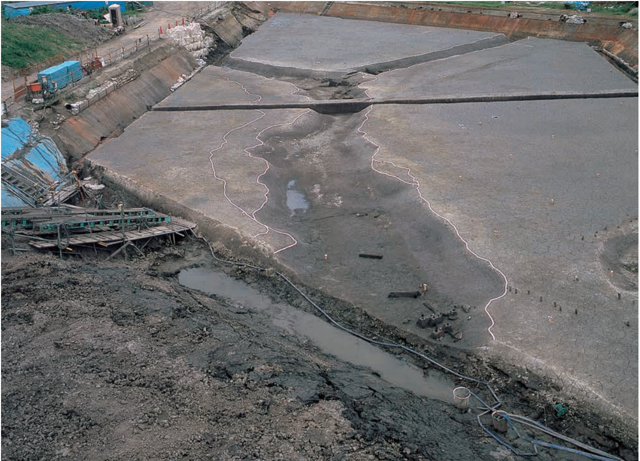
(1) 第1面 流路1 (03-5-4トレンチ 南西から)
