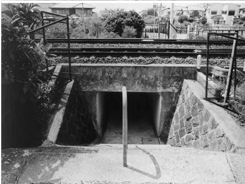
3. 新田避溢函渠
